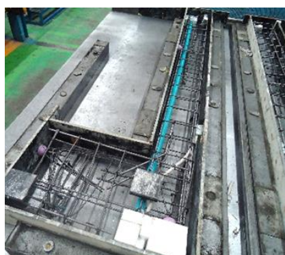
รูปภาพที่ 51 การวางท่อในผนังของโรงงาน
