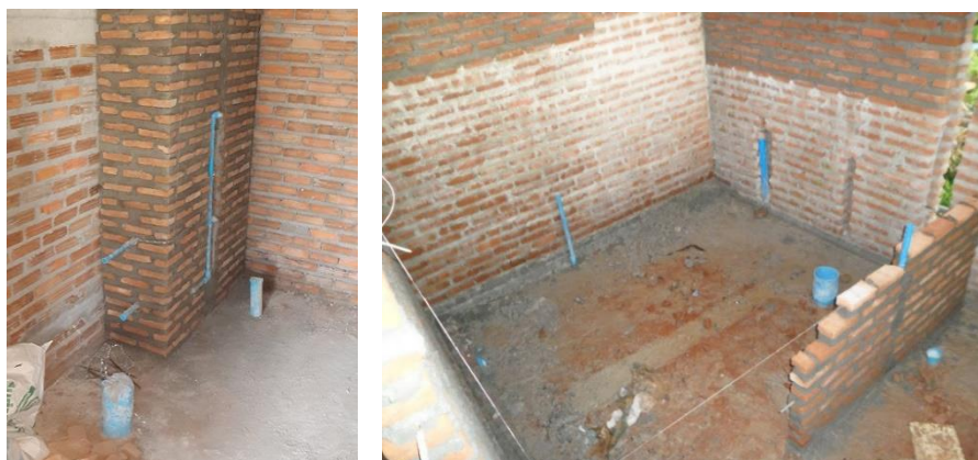
รูปภาพที่ 13 การก่อสร้างห้องน้ำแบบทั่วไป 16
