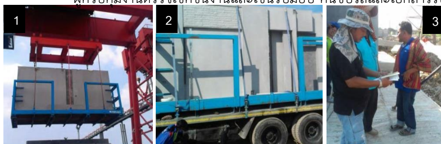
รูปภาพที่ 39 การขนส่งแผ่นผนังและแผ่นพื้นห้องน้ำคอนกรีตสำเร็จรูป
