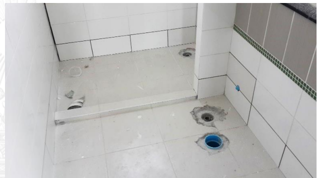
ตำแหน่งแนวท่อเดินไม่ตรงกับการใช้งาน
