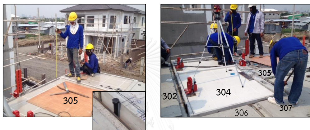
รูปภาพที่ 40 การดำเนินการติดตั้งผนังห้องน้ำภายในโครงการเดอะแพลนท์ เอสทีค เขตพัฒนาการ ที่มา : ผู้วิจัย, 2558
