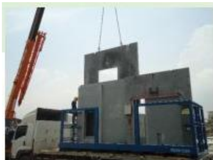
รูปภาพที่ 52 การขนส่งชิ้นส่วนผนังคอนกรีตสำเร็จรูปโครงการเดอะแพลนท์ เอสทีดี พัฒนาการ ที่มา : ผู้วิจัย, 2558
