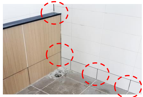
รูปภาพที่ 53 การติดตั้งผนังชิดกันทำให้ขอบ กระเบื้องบิ่น
