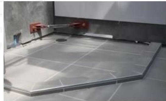
รูปภาพที่ 56 การปรับความลาดเอียงของพื้นกระเบื้องห้องน้ำ
