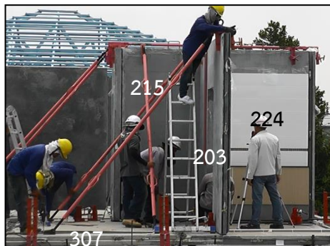
รูปภาพที่ 45 การตรวจสอบแนวระดับและแนวกระเบื้อง ของโครงการเดอะแพลนท์ เอสทีค เขตพัฒนาการ ที่มา : ผู้วิจัย, 2558
