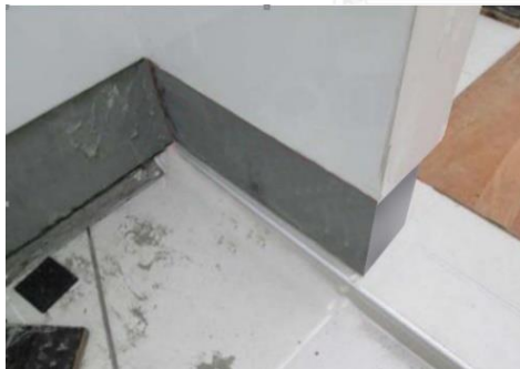
รูปภาพที่ 56 การปรับความลาดเอียงของพื้นกระเบื้องห้องน้ำ
