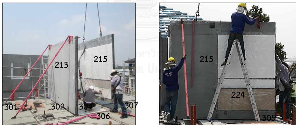
รูปภาพที่ 42 การตรวจสอบและปรับระดับแนวผนังของโครงการเดอะแพลนท์ เอสทีค เขตพัฒนาการ ที่มา : ผู้วิจัย, 2558
