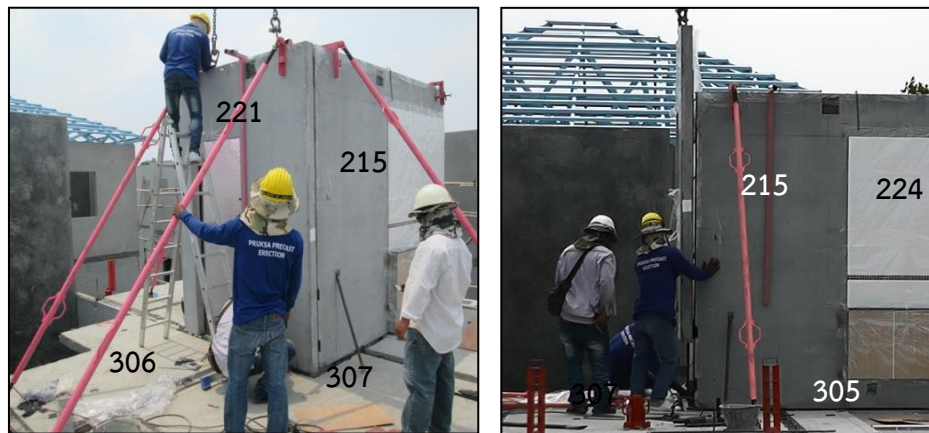
รูปภาพที่ 43 การติดตั้งแผ่นผนังของโครงการเดอะแพลนท์ เอสทีเค เขตพัฒนาการ (ต่อ)
