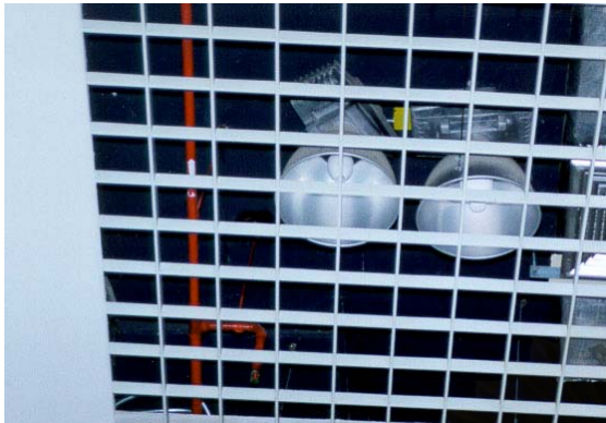
รูปที่ 3.30 แสดงโคม Highbay คู่หลอด Metal Halide, High Pressure Sodium ใช้ในบริเวณโรงพักคอยชั้นล่าง
