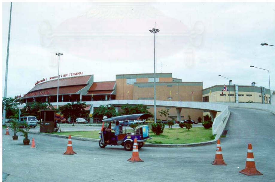
รูปที่ 3.1 แสดงผังบริเวณของอาคารสถานีขนส่งหมอชิต 2
