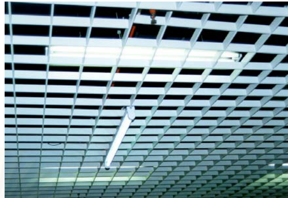
รูปที่ 3.31 แสดงหลอดไฟ ฟลูออเรสเซนต์ ที่ใช้ในอาคาร
