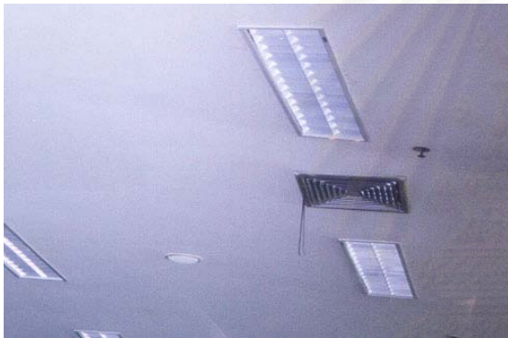
รูปที่ 3.32 แสดงหลอดไฟ ฟลูออเรสเซนต์ แบบฝังในฝ้า พร้อมตะแกรง และแผ่นสะท้อนแสง Aluminium.
