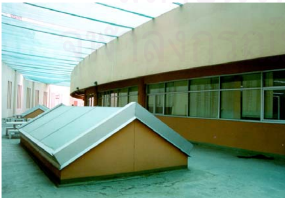
รูปที่ 3.28 แสดงช่องแสงด้านบนบริเวณหลังคาชั้น 1.
