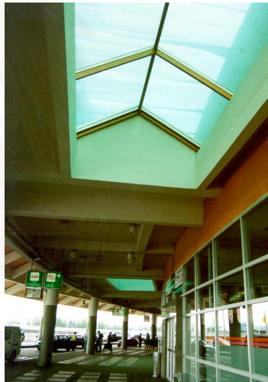
รูปที่ 3.19 แสดงช่องแสงด้านบนบริเวณทางเดิน ภายนอกอาคารที่ชั้น 1.
