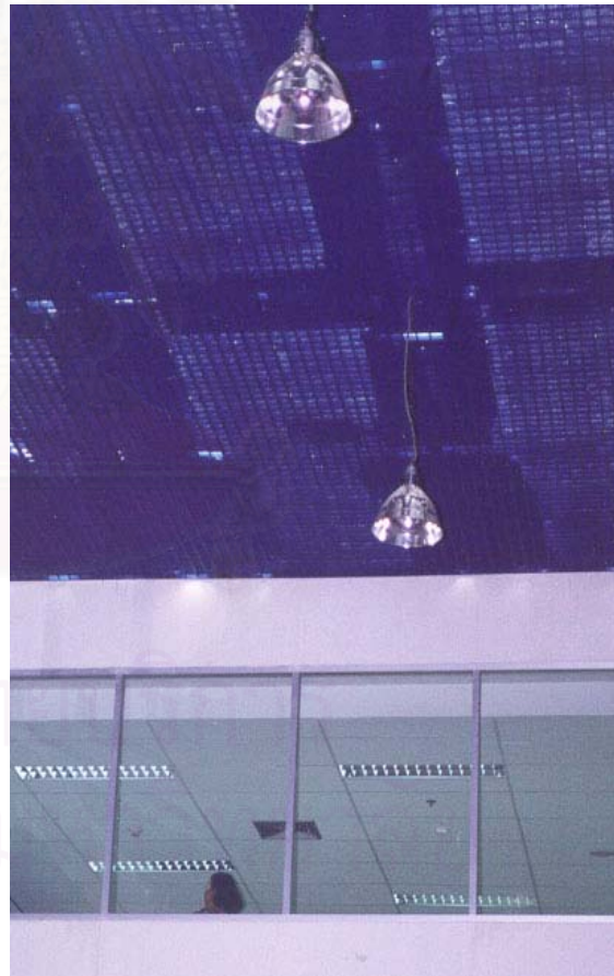
รูปที่ 3.33 แสดงโคม highbay คู่หลอด metal halide ใช้ในบริเวณโรง double space ที่ชั้น 1.
