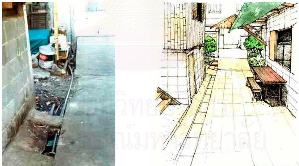
ภาพที่ 7.7 แสดงทางระบายน้ำบริเวณทางเข้าหลัก 3 ก่อนปรับปรุง
