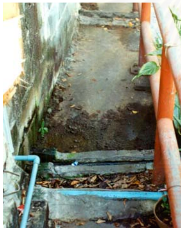
ภาพที่ 5.16 แสดงทางระบายน้ำด้านเหนือของชุมชนบริเวณที่ติดคลองสาธารณะ
