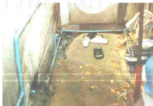
ภาพที่ 5.26 ขยะที่ลงในรางระบายน้ำเกิดอุดตัน
