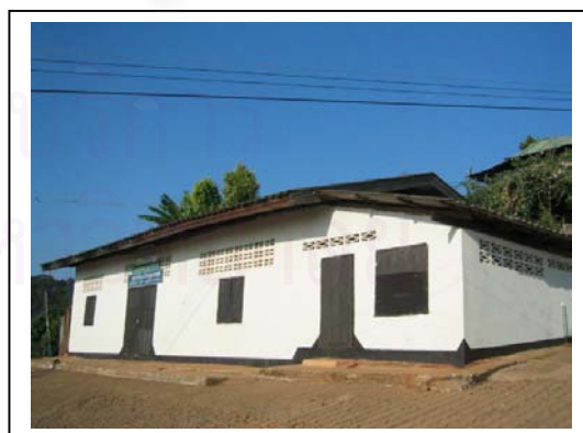
รูปที่ 4.16 ศูนย์ข้อมูลสุขภาพหมู่บ้าน สร้างด้วยอิฐบล็อกทาสี หลังคามุงกระเบื้อง
