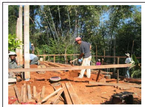
บ้านหลังใหม่ กำลังจะสร้างเป็นคอนกรีตเสริมเหล็ก
