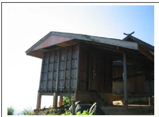
รูปที่ 4.17 ธนาคารข้าว สร้างด้วยวัสดุถาวร โครงสร้างหลักเป็น คสล. ผนังไม้แผ่น หลังคามุงกระเบื้อง
