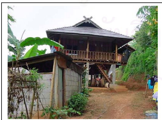
รูปที่ 5.26 ตัวอย่างบ้านสองชั้นที่มีการใช้วัสดุแบบถาวรทั้งหลัง โครงสร้างหลักชั้นล่างเป็น คสล. ชั้นบนเป็นไม้จริงผนังและพื้นเป็นไม้แผ่น แปรรูป หลังคามุงกระเบื้อง
