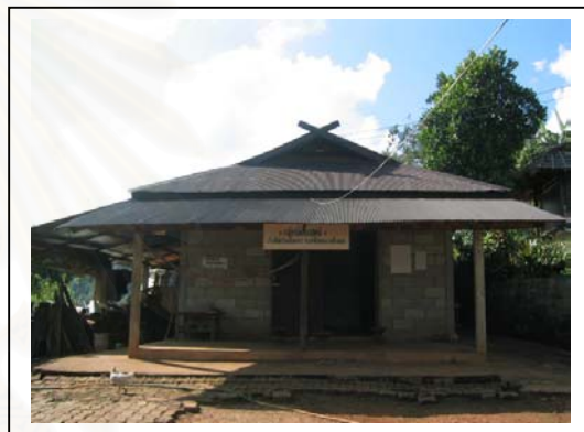
รูปที่ 5.25 ตัวอย่างบ้านที่ใช้วัสดุแบบสมัยใหม่ คือ หลังคาสังกะสี โครงสร้างหลัก คสล. ผนังก่ออิฐบล็อก ไม่ฉาบเรียบ ไม่ทาสี ประตู-หน้าต่างเป็นไม้
