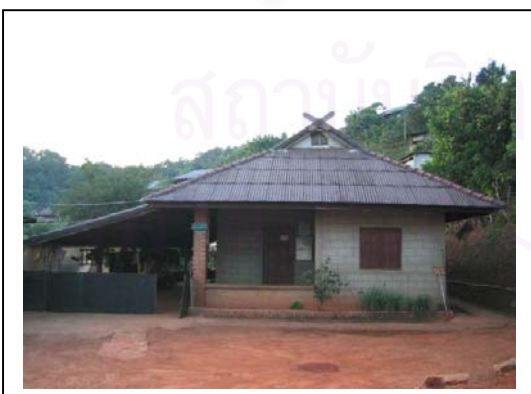
รูปที่ 4.37 ตัวอย่างบ้านแบบประยุกต์ สร้างด้วยวัสดุ ถาวรทั้งหลัง โครงสร้างหลักเป็น คสล. พื้นเป็นคอนกรีต ผนังอิฐบล็อก หลังคา มุงกระเบื้อง แต่ผนังภายในเป็นแบบดั้งเดิม
