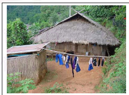
รูปที่ 5.11 บ้านนอกพื้นที่ ที่ยังไม่ได้รับอนุญาต (หลังคาเรือนที่ 80)
