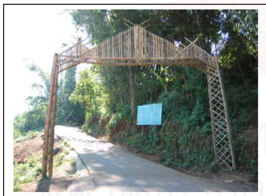
รูปที่ 4.9 ประตูทางเข้าหมู่บ้าน (ยะซ่อ) สร้างด้วยไม้ไผ่ สูงประมาณ 3 เมตร
