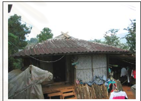
รูปที่ 4.36 ตัวอย่างบ้านแบบประยุกต์ สร้างด้วยวัสดุ กึ่งถาวร โครงสร้างหลักเป็น คสล. ผนังไม้ ผนังฟากไม้ไผ่ หลังคามุงกระเบื้อง
