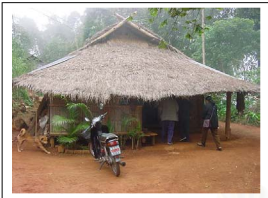
รูปที่ 5.22 ตัวอย่างบ้านที่ใช้วัสดุแบบดั้งเดิม คือ หลังคาหญ้าคา โครงสร้างหลักไม้จริง ผนังฝาไม้ไผ่ ไม่มีหน้าต่าง
