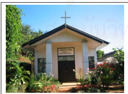
รูปที่ 4.21 โบสถ์ของชาวอาข่าในหมู่บ้านที่นับถือศาสนาคริสต์ สร้างด้วยวัสดุถาวร โครงสร้างหลักและผนังเป็น คสล. หลังคามุงกระเบื้อง ประตูหน้าต่างเป็นบานเปิดกระจกใส
