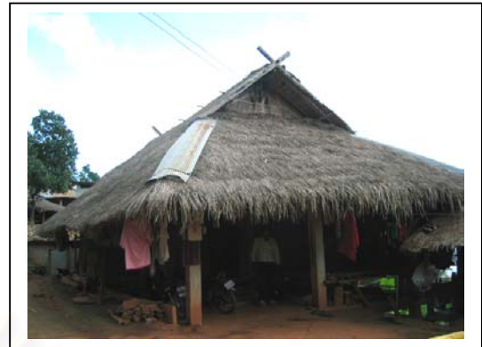
รูปที่ 4.34 ตัวอย่างบ้านแบบดั้งเดิมสร้างด้วยวัสดุ กึ่งถาวร เสาคือ คสล. หลังคาหญ้าคา ผนังฟากไม้ไผ่
