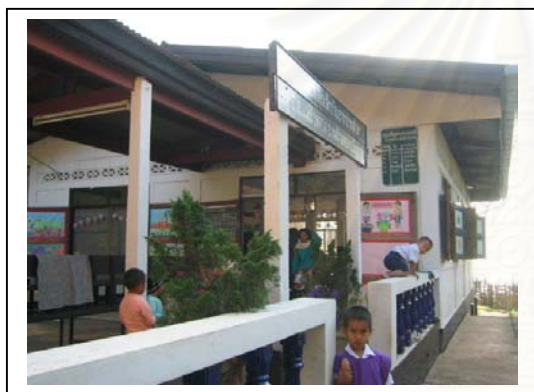
รูปที่ 4.19 ศูนย์พัฒนาเด็กเล็กบ้านอีโก้ปากกล้วย สร้างด้วยวัสดุถาวร โครงสร้างหลักและผนังเป็น คสล. หลังคามุงกระเบื้อง
