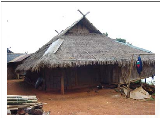
รูปที่ 4.33 ตัวอย่างบ้านแบบดั้งเดิมสร้างด้วยวัสดุ ไม้ถาวรทั้งหลัง
