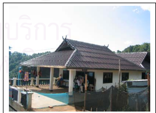
รูปที่ 4.38 ตัวอย่างบ้านแบบสมัยใหม่ สร้างด้วยวัสดุ ถาวรทั้งหลัง และมีการใช้ประตู-หน้าต่าง กระจกบานเลื่อน กรอบอลูมิเนียม
