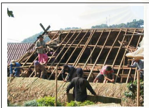
รูปที่ 5.72 กลุ่มชาวบ้านกำลังช่วยกันเปลี่ยนหลังคา หน้ำคาที่หมดสภาพการใช้งาน
