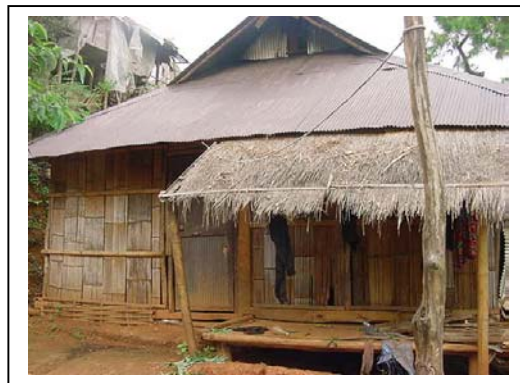
รูปที่ 5.23 ตัวอย่างบ้านแบบกิ่งถาวร ที่มีโครงสร้างหลักเป็นเสาจริง ผนังฝาไม้ไผ่ ประตูสังกะสี ไม่มีหน้าต่าง
