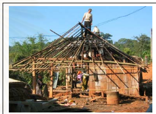
รูปที่ 5.73 กลุ่มชาวบ้านที่กำลังรื้อบ้านหลังเก่าที่ วัสดุหมดสภาพการใช้งานแล้ว แต่ก็ จะสร้างโดยใช้วัสดุแบบไม่ถาวรเช่นเดิม
