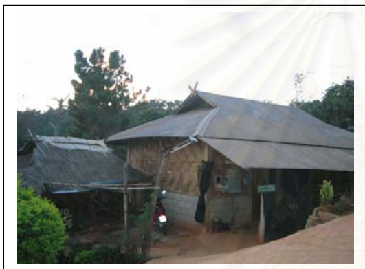
รูปที่ 5.24 ตัวอย่างบ้านที่ใช้วัสดุแบบผสมผสาน คือ หลังคาสังกะสี โครงสร้างหลัก คสล. ผนังก่ออิฐบล็อก ไม่ฉาบเรียบไม่ทาสี สูง 1.00 ม. ส่วนที่เหลือเป็นฝาไม้ไผ่ ไม่มีหน้าต่าง
