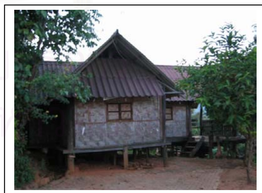
รูปที่ 4.22 บ้านพักเจ้าหน้าที่ สร้างด้วยโครงสร้างหลักไม้จริง พื้นไม้แผ่นแปรรูป ผนังฝาไม้ไผ่สาน หลังคามุงกระเบื้อง
