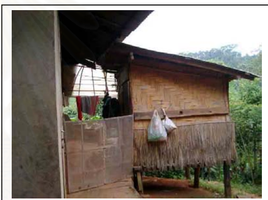
รูปที่ 5.46 เรือนหลังเล็กที่แยกออกจากเรือนหลังใหญ่ โดยการต่อเติมออกด้านข้าง
