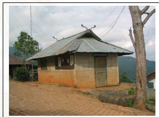
รูปที่ 4.20 ศูนย์สาธารณสุขหมู่บ้าน ก่อสร้างด้วยอิฐบล็อกไม่ทาสี หลังคามุงสังกะสี ปัจจุบันใช้เป็นหอกระจายเสียง
