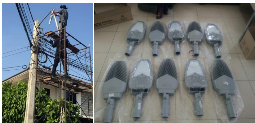
รูปภาพที่ 33 แสดงตัวอย่างการปรับเปลี่ยนชนิดของหลอดไฟ LED
