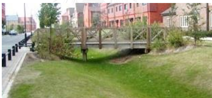
ภาพที่ 114 ระบบทางระบายน้ำที่มีพืชพรรณปกคลุม (Stephenson, 2014)
