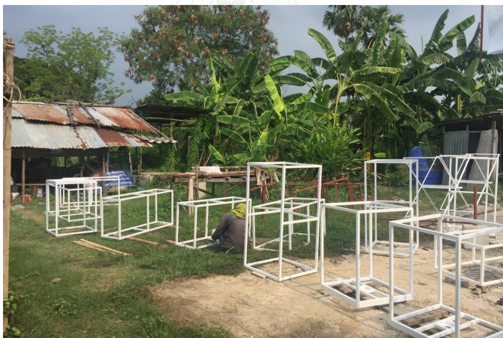
รูป 4-28 ขั้นตอนการเตรียมชิ้นส่วนของศาลาเห็นลม
