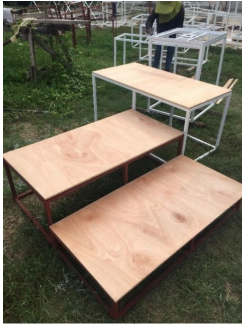
รูป 4-29 ขั้นตอนการเตรียมโครงพื้นส่วนใช้งานของศาลาเห็นลม
