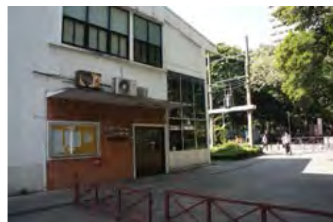
(d) บริเวณอาคารปฏิบัติการไฟฟ้าแรงสูง
