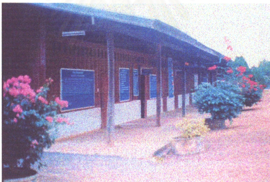
รูปที่ 1 สภาพอาคารเรียนโรงเรียนตำรวจตระเวนชายแดน ก
