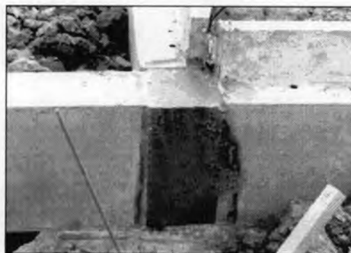
รูปที่ 5.72 แสดงการเทคอนกรีตยึดคาน
