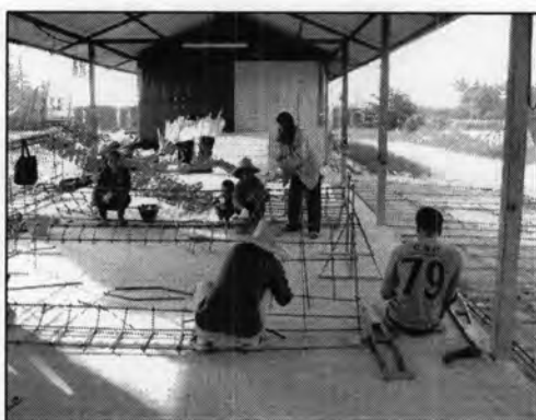
รูปที่ 5.29 ภาพแสดงการผูกเหล็กผนัง
