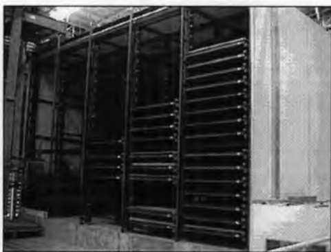
รูปที่ 5.16 แสดงส่วนห้องบ่มคอนกรีต
