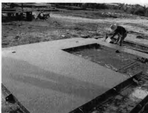
รูปที่ 5.51 แสดงการปาดผิวคอนกรีต
