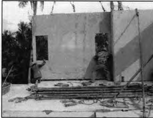
รูปที่ 5.102 แสดงการยกติดตั้งผนังชั้น 2
