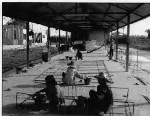
รูปที่ 5.27 ภาพแสดงโรงผูกเหล็กเสริม
