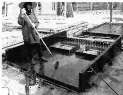
รูปที่ 5.41 แสดงวิธีการทาน้ำมันเคลือบแบบ
