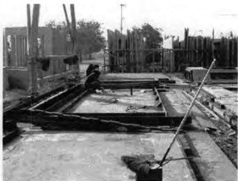
รูปที่ 5.40 แสดงการเชื่อมยึดแบบด้านข้าง
