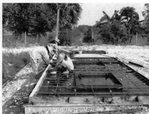
รูปที่ 5.43 แสดงการผูกเหล็กตะแกรง
