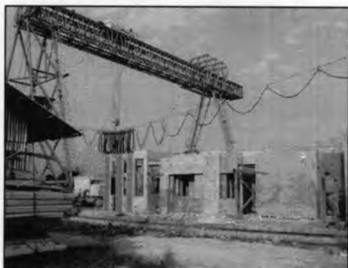
รูปที่ 5.33 ภาพแสดงเครนที่ใช้ในการกองแผ่น
