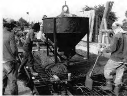
รูปที่ 5.48 แสดงขั้นตอนขณะเทคอนกรีต
