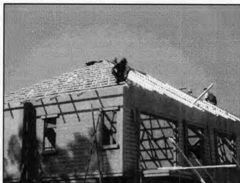
รูปที่ 5.111 แสดงงานหลังคาเหล็กชุบสังกะสี
