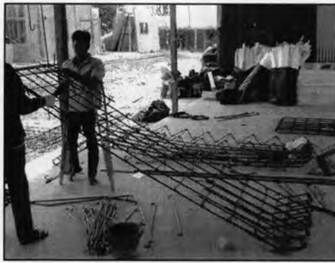
รูปที่ 5.30 ภาพแสดงการผูกเหล็กบันได
