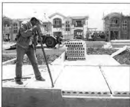
รูปที่ 5.73 แสดงงานวางพื้นสำเร็จรูปชั้นล่าง
