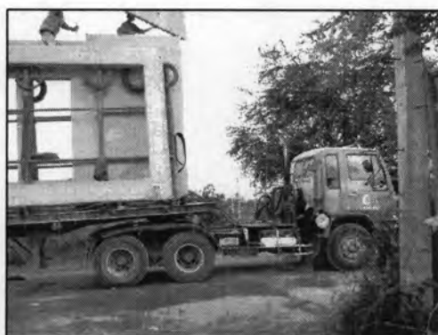
รูปที่ 5.66 แสดงรถเทรลเลอร์ที่ใช้ขนย้ายแผ่น
