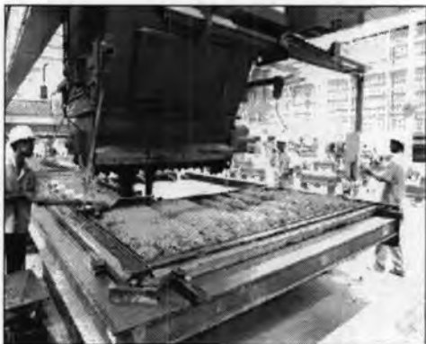
รูปที่ 5.10 แสดงการเทคอนกรีตโดยเครื่องจักร
