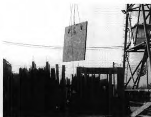
รูปที่ 5.58 แสดงขั้นตอนการยกแผ่นรูปที่4
