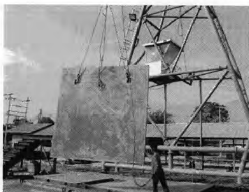
รูปที่ 5.57 แสดงขั้นตอนการยกแผ่นรูปที่3
