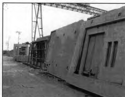
รูปที่ 5.34 ภาพแสดงการเก็บแผ่นผนัง
