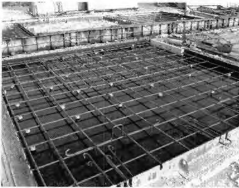
รูปที่ 5.45 แสดงการหนูนลูปเหล็ก
