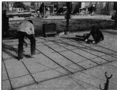
รูปที่ 5.28 ภาพแสดงการผูกเหล็กเสริม
