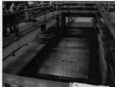
รูปที่ 5.7 แสดงการวางเหล็กกันข้างแบบ
