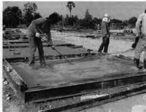
รูปที่ 5.38 การใช้เหล็กขูดทำความสะอาด
