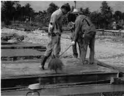
รูปที่ 5.37 แสดงการทำความสะอาดแบบหล่อ
