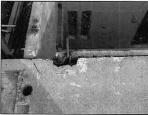
รูปที่ 5.100 ลักษณะการเชื่อมยึดพื้นกับผนัง
