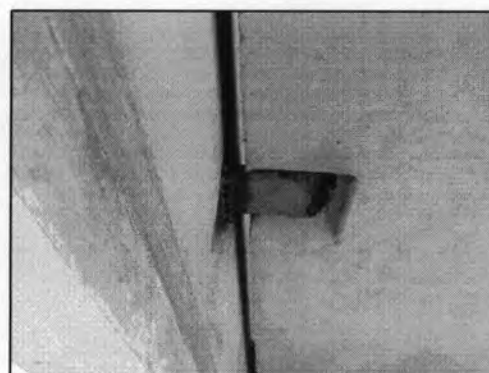
รูปที่ 5.96 แสดงลักษณะการเชื่อมยึดผนัง
