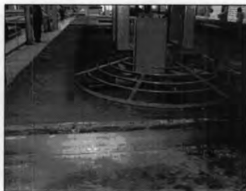
รูปที่ 5.15 แสดงเครื่องขัดผิวคอนกรีต
