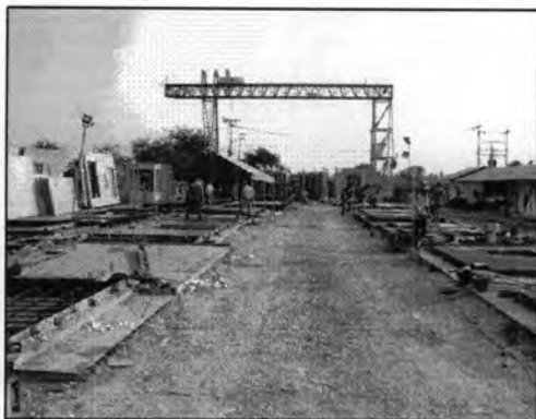
รูปที่ 5.31 ภาพแสดงลานแบบหล่อคอนกรีต
