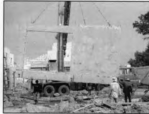
รูปที่ 5.88 แสดงการยกแผ่นเพื่อเตรียมติดตั้ง
