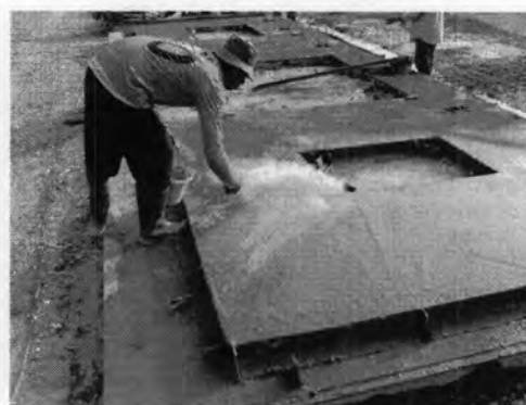
รูปที่ 5.52 แสดงการโรยผงปูนเพื่อเก็บผิวหน้า
