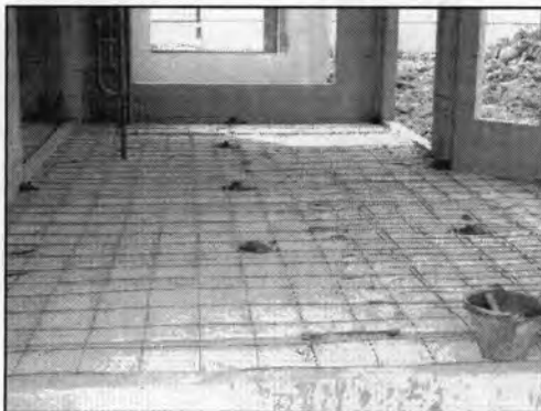
รูปที่ 5.104 แสดงงานวางพื้นสำเร็จรูปชั้นล่าง
