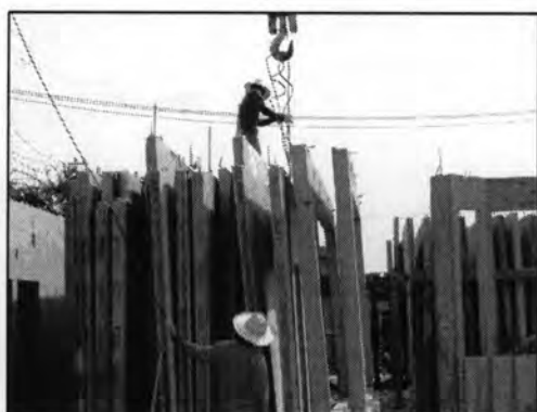
รูปที่ 5.63 แสดงการใช้เครนวางแผ่นยกขึ้นงาน
