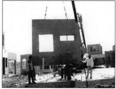
รูปที่ 5.76 การยกติดตั้งผนังสำเร็จรูปชั้นล่าง
