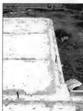
รูปที่ 5.74 แสดงเทคอนกรีตยึดพื้นกับคาน
