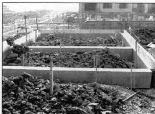
รูปที่ 5.69 แสดงการวางคานสำเร็จรูป
