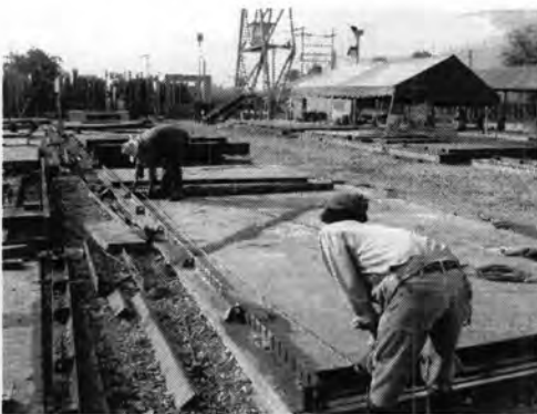
รูปที่ 5.39 แสดงการวัดระยะเพื่อกำหนดขนาดแผ่น
