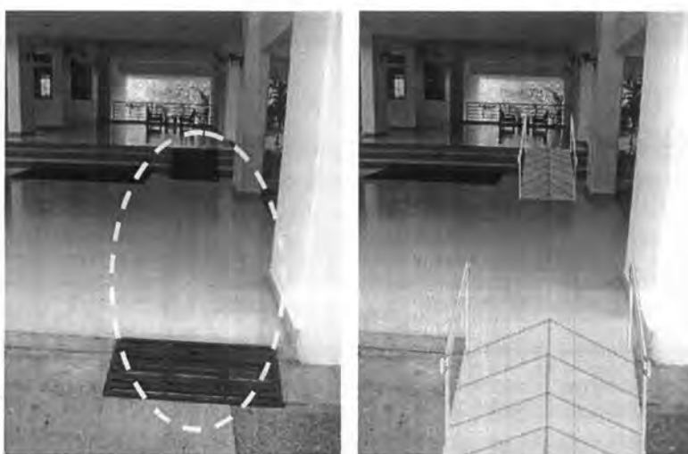
ภาพที่ 6.19 แนวทางการปรับปรุงทางลาดภายในอาคาร โครงการ ROYAL CLIFF GARDEN SUIT
