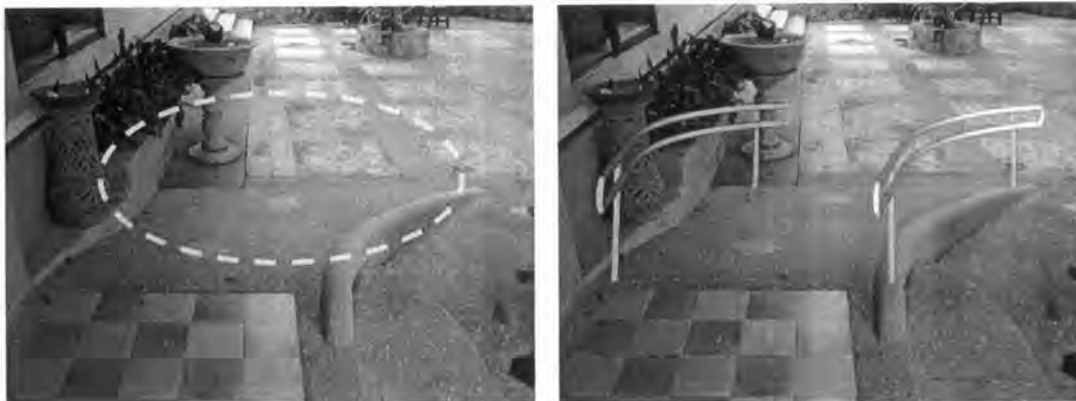
ภาพที่ 6.24 แนวทางการปรับปรุงทางลาด โครงการ DIANA GARDEN RESORT
