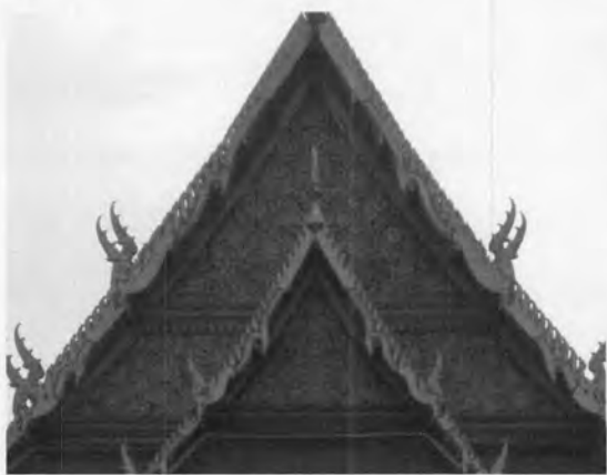
ภาพที่ 4.2 หลังคาพระวิหารใหญ่ซ้อนจั่วหลังคามุขเล็ก
