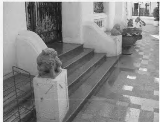
ภาพที่ 4.48 ผนังพลสังกัห้หน้าบัน ฐานชั้นล่างก่อโค้งผายออก ปลายผนังก่อเสาประดับยอดด้วยสิงโตจีนแกะสลัก
