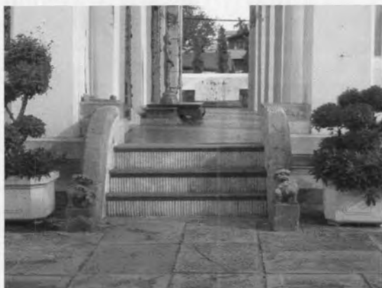
ภาพที่ 4.17 ฐานชั้นล่างเป็นฐานสิงห์ไม่มีลูกแก้ว พนักพลสิงห์ก่อโค้ง สันพนักเป็นหินทรายจีนแกะสลัก
