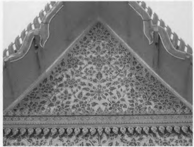
ภาพที่ 4.218 หน้าบันพระวิหาร แกะสลักฝังกระจก เป็นลายดอกพุดตาน
