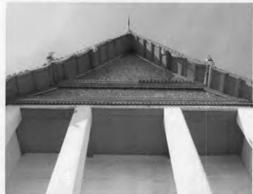
ภาพที่ 4.60 บริเวณผนังคอสองรับช่อหน้าบัน
