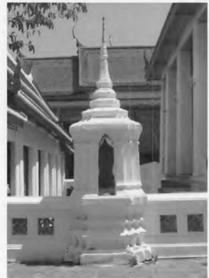
ภาพที่ 4.212 ซุ้มเสมาเครื่องยอดเจดีย์ กำแพงแก้วติดกระเบื้องปรุเหมือนกับพระอุโบสถ
