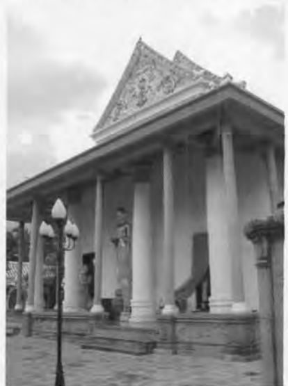
ภาพที่ 4.92 รูปค้ำด้านหน้าของพระอุโบสถอาจเหมือนค้ำด้านหลังหากมุขหน้าเป็นส่วนต่อเติม
