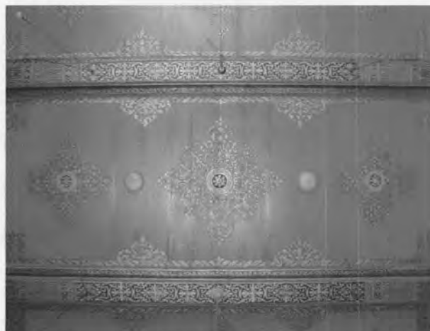
ภาพที่ 4.233 ฝาเพดานภายใน เขียนสีปิดทองกำมะลอเป็นลายพฤกษชาติแบบเทศ
