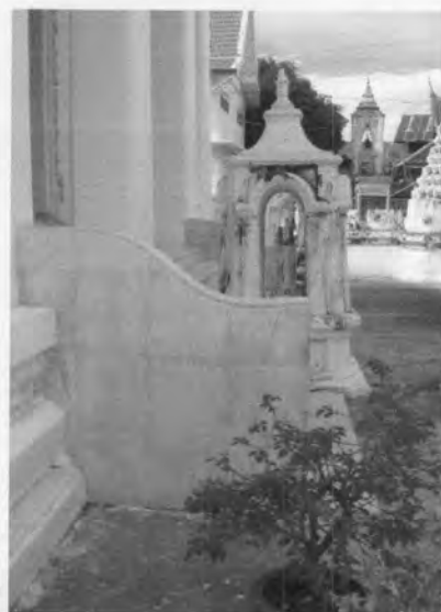
ภาพที่ 4.116 ฐานอาคารเป็นฐานสิงห์ไม่มีลูกแก้ว ผนังพลสังห์ก่อโค้งผิวบุหินอ่อน
