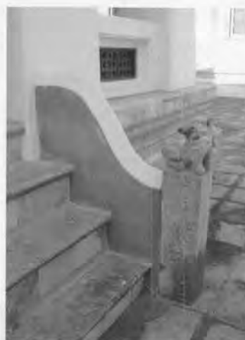
ภาพที่ 4.231 ฐานอาคารเป็นปัทม์ ซ่อมด้วยคอนกรีตสมัยใหม่ ผนังพลสังห่อไค้ ปลายผนังตั้งเสาหินแกะสลักยอดเสาเป็นรูปสิงโตจีน
