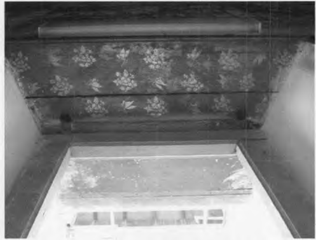
ภาพที่ 4.38 ทับหลังด้านในปิดทองลายฉลุเป็นลาย ดอกพุดตานและผีเสื้อเหมือนด้านนอก
