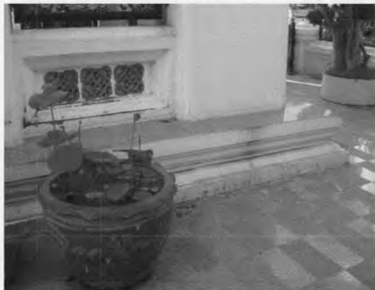
ภาพที่ 4.47 ฐานชั้นล่างเป็นฐานปัทม์ ผนังระเบียงก่ออิฐถือปูนหนา เสาช่องหน้าต่างกระดานคดกระเบื้องปรู
