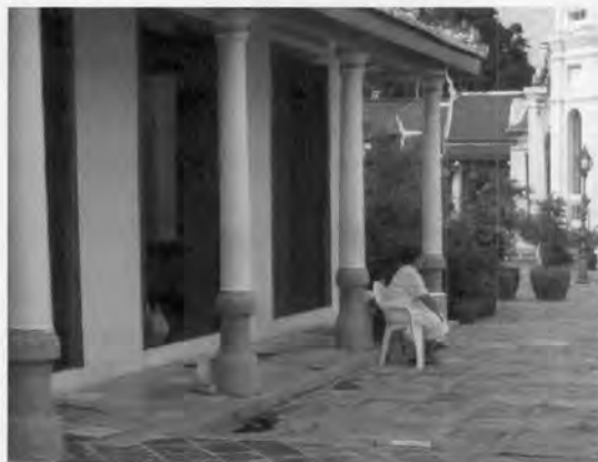
ภาพที่ 4.82 ฐานอาคารส่วนมุขหน้าเป็นฐานเชิงสูงจากพื้นลานรอบประมาณ 1 ชั้นบันได
