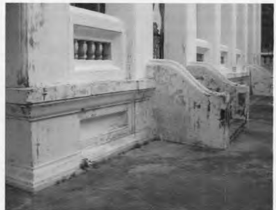
ภาพที่ 4.65 ฐานอาคารเป็นฐานปัทม์ ย่อกระเปาะตรงกับเสา ระเบียง กลางท้องไม้ก่ดเป็นช่องลูกฟักกลิ้งไปเล็กน้อย
