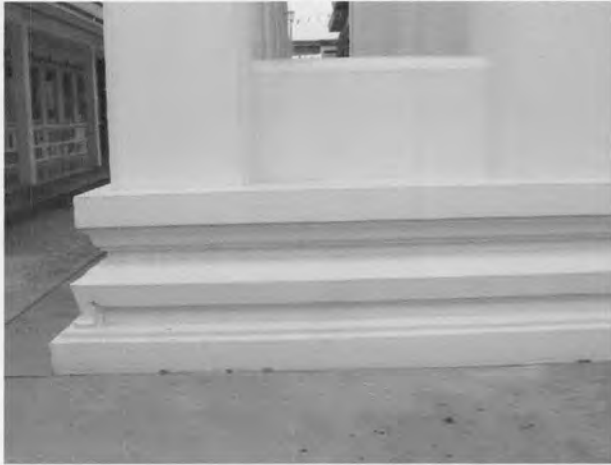
ภาพที่ 4.194 ฐานอาคาร ลักษณะเหมือนกับฐานพระอุโบสถ พนักพลสังห์ก่อตัน ไม่ประดับกระเบื้องปฐ
