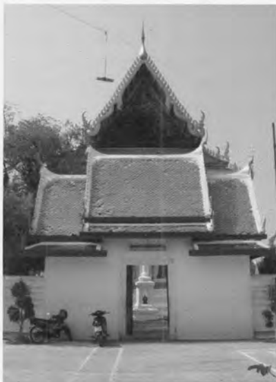
ภาพที่ 4.267 ศาลาซุ้มทางเข้าด้านหน้าพระอุโบสถ
