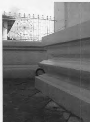
ภาพที่ 4.8 ฐานชั้นบน เป็นฐานปัทม์ แต่ไม่มีชั้นบัวคว่ำ
