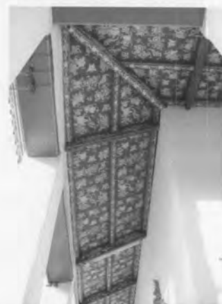
ภาพที่ 4.134 ฝาเพดานภายนอกเขียนสีเป็นลายดอกไม้ ฝีเสื้อ และค้างคาว
