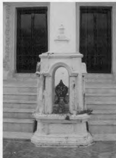
ภาพที่ 4.121 ชุ่มเสมาก่ออิฐถือปูนทรงเทศ ชุ่ม ด้านหน้าและหลังตั้งแทรกบันไดทางขึ้นระเบียง
