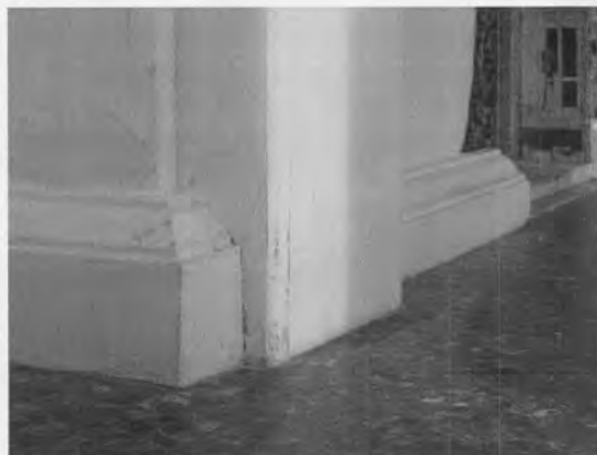
ภาพที่ 4.18 ฐานชั้นบน เป็นฐานบัวคว่ำ ผนังด้านสกัดก่อเสาแบบทั้งสองฟาก
