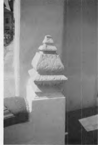
ภาพที่ 4.241 เสาปลายพนัก ยอดประดับหัวเม็ดเหลี่ยมหินอ่อน
