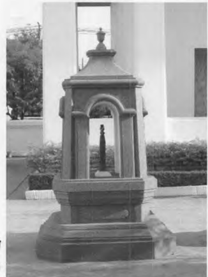
ภาพที่ 4.190 ซุ้มเสมาทรงเทศ ได้รับการซ่อมผิวเป็นวัสดุสมัยใหม่ คือ กรวดล้างสีน้ำตาล
