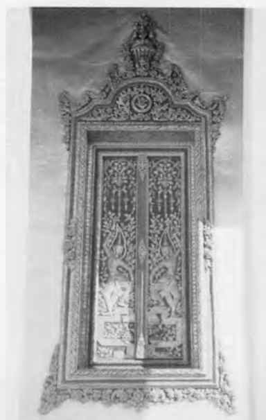
ภาพที่ 6.47 บานหน้าต่างปูนปั้นปิดทองบนบานไม้ วิหารพระพุทธไสยาสน์ วัดราชโอรสาราม
