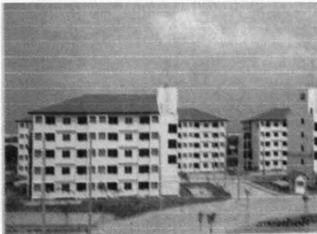
ภาพที่ 4.1 ภาพแสดงอาคารชุดพักอาศัยในโครงการบ้านเอื้ออาทร
