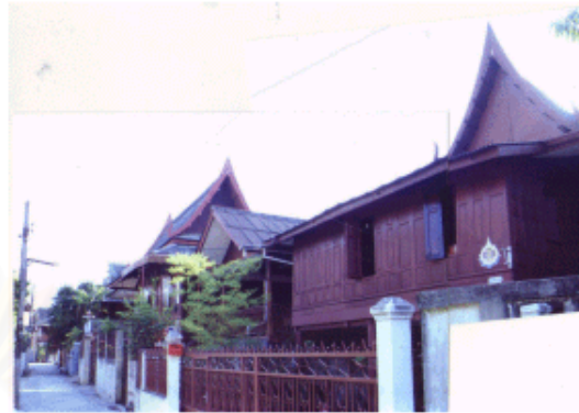
แนวรั้วคอนกรีตบล็อก
