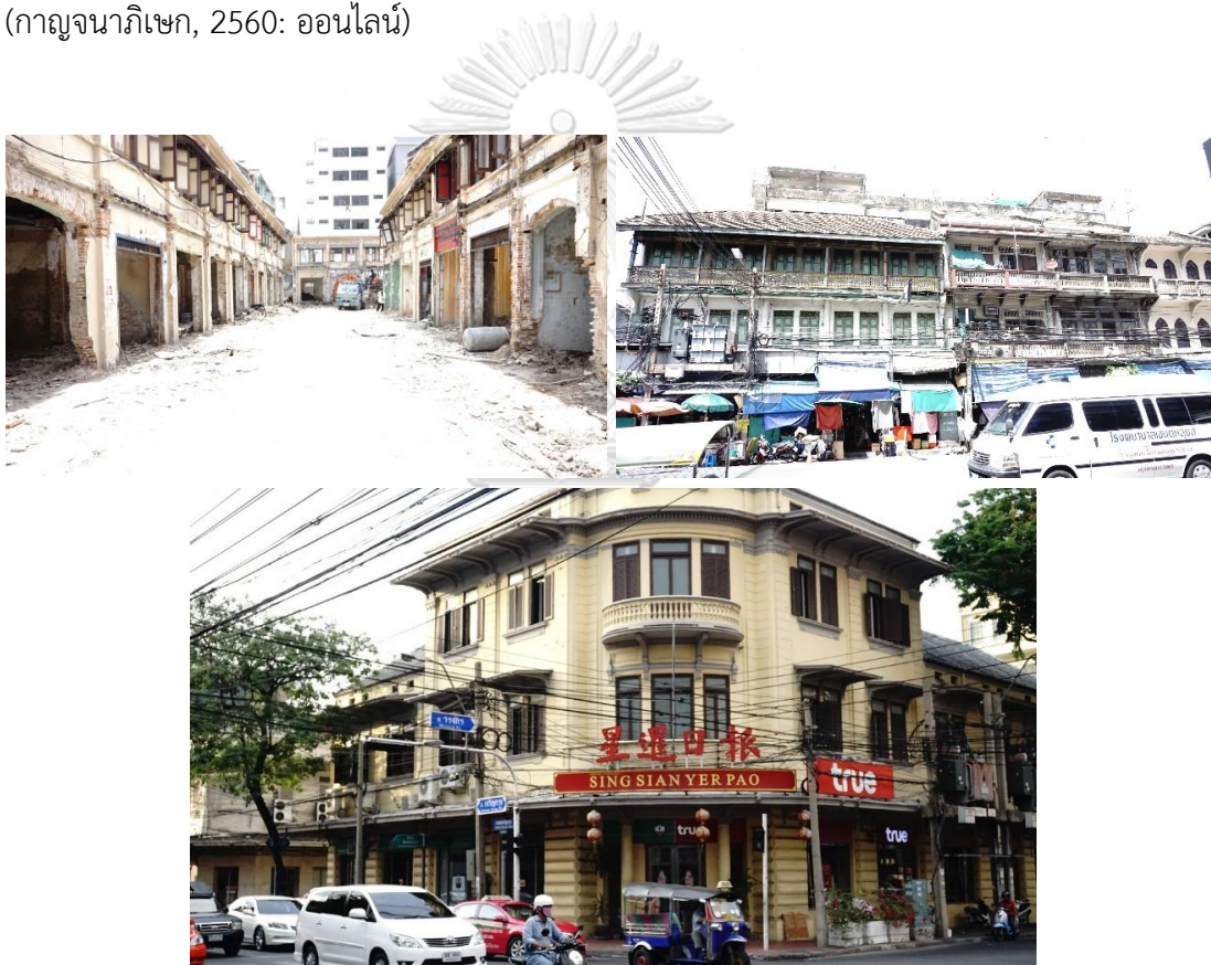
ภาพที่ 11 ภาพแสดงพื้นที่เขตเยาวราช ภาพซ้ายด้านบน คือพื้นที่ปรับปรุงชุมชนเลื่อนฤทธิ์ ภาพขวาด้านบน คือถนนสำเพ็ง และภาพด้านล่าง คือสี่แยกวรจักรติดกับถนนเจริญกรุง
