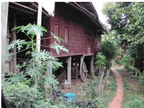
รูปภาพ 3.5 เรือนฝาปะกนที่ ต.สร้อยฟ้า
