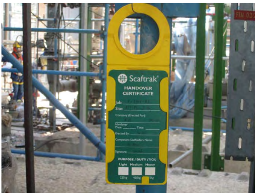
ภาพที่ 8.9 Tag Card สำหรับการติดตั้งที่นังร้าน
