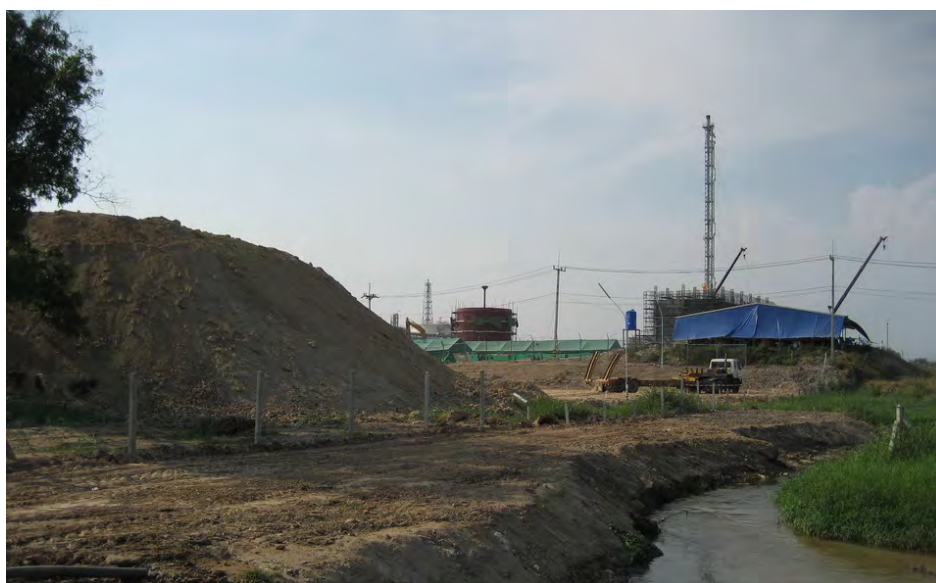
ภาพที่ 8.1 การปักเสาแบ่งแนวเขตแม่น้ำและพื้นที่ก่อสร้าง
