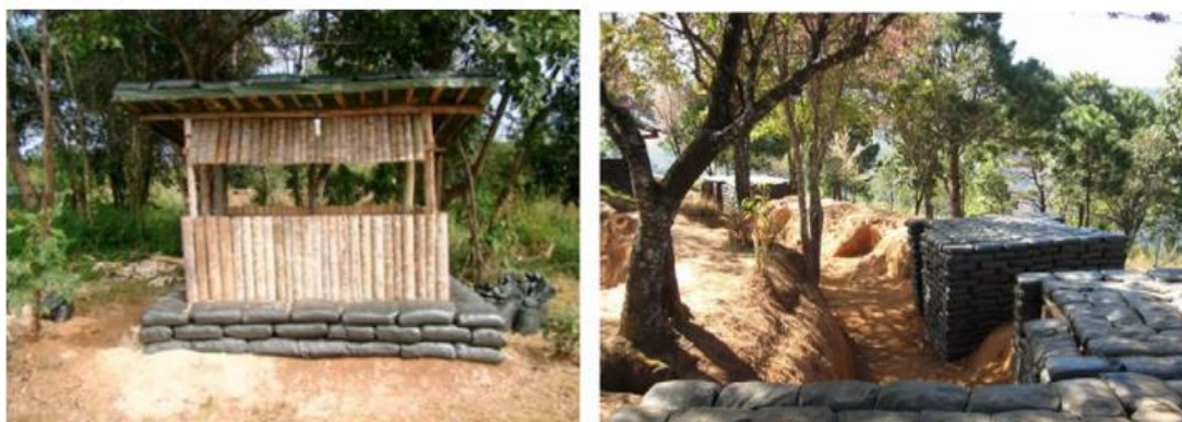
รูปที่ 2.1 รูปแบบป้อมสนามที่ใช้กระสอบบรรจุทราย [4]
