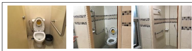
รูปที่ 22 ห้องน้ำพื้นที่ส่วนกลาง
