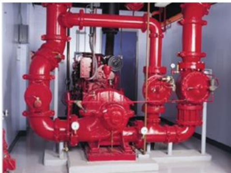
รูปที่ 2.33 เครื่องสูบน้ำดับเพลิงชนิดแรงเหวี่ยงหนีศูนย์กลาง แบบ Horizontal Split-Case
