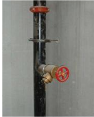
รูปที่ 2. 36 ท่อยื่นประเภทที่ 1 ประกอบด้วยวาล์วสายฉีดน้ำดับเพลิงขนาด 2 1/2 นิ้ว
