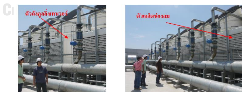
รูปที่ 2. 11 ตัวถังคูลลิ่งทาวเวอร์ (Casing) รูปที่ตัวเกล็ดช่องลม (Louver) ดูดอากาศเข้า
