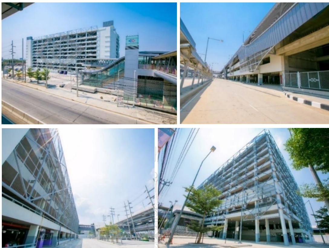
ภาพที่ 3 อาคารจอดแล้วจรรถไฟฟ้าสายสีม่วง
