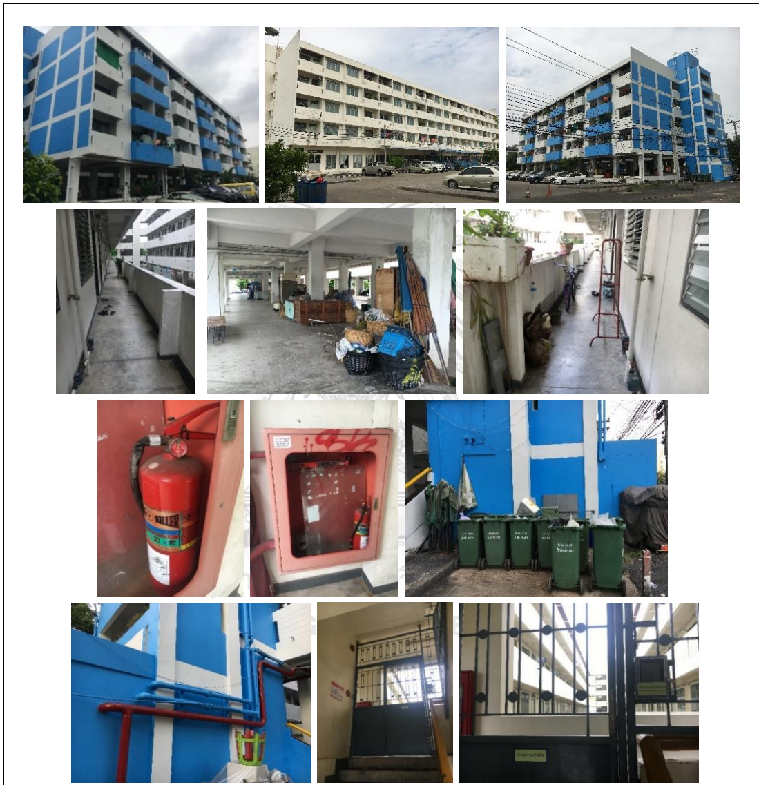
รูปภาพที่ 5 แสดงสภาพกายภาพของอาคารที่พักอาศัยส่วนกลาง พื้นที่สุขสวัสดิ์ 26
