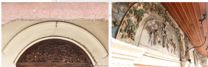
ภาพที่ 15 งานไม้ฉลุตกแต่ง หน้าร้าน VILA CINI (รูปซ้าย) และงานปูนปั้นตกแต่งกระเบื้องหน้าร้าน The Gallery (รูปขวา) งานตกแต่งอาคารเรือนแถวที่รับอิทธิพลจากจีนบนถนนเจริญราษฎร์ ย่านวัดเกตการาม ที่มา: ผู้วิจัย (2561)
