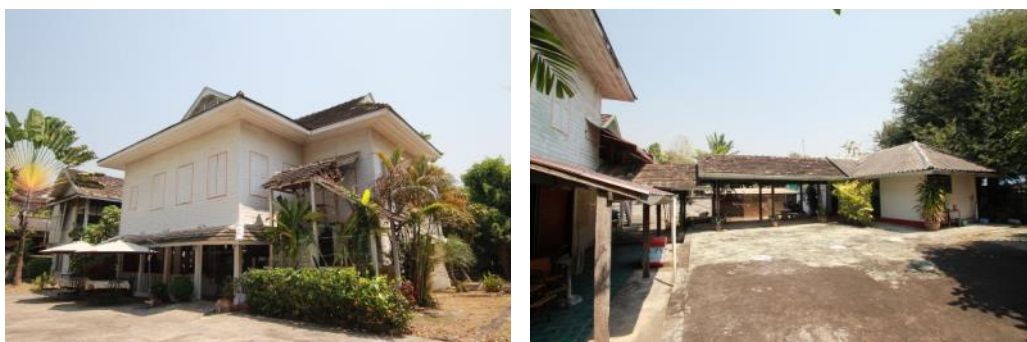
ภาพที่ 59 ภาพรวมของโครงการร้าน Arcobalenoด้านหน้าอาคาร (ด้านซ้าย) และด้านหลังอาคารที่เชื่อมต่อกับอาคารห้องน้ำที่ถูกสร้างขึ้นภายหลัง (ด้านขวา)
