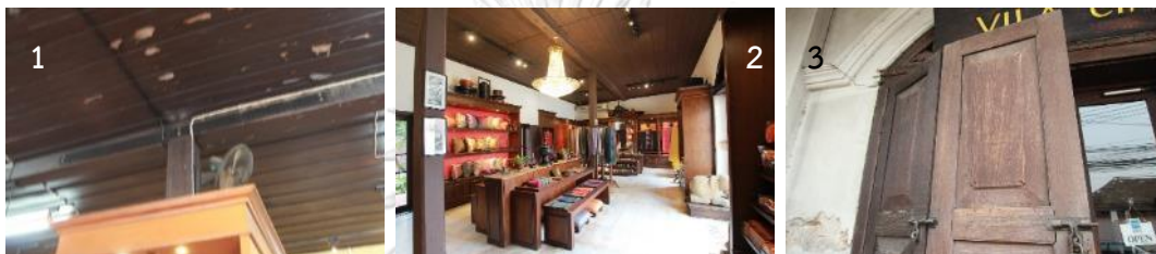
ภาพที่ 68 การตามคานไม้เดิมด้วยเหล็ก (1) การตกแต่งภายในด้วยไม้ให้ดูกลมกลืนกับอาคารเดิม (2) และการรักษาบานเพ็ญไม้เดิมและอุปกรณ์ของประตูด้านหน้าเอาไว้ แล้วมีการเพิ่มประตูกระจกด้านใน (3) ที่มา : ผู้วิจัย (2561)
