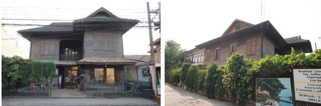
ภาพที่ 50 ภาพรวมของโครงการร้าน The Meeting Room Art Café ด้านหน้าร้านจากถนนเจริญราษฎร์ (ด้านซ้าย) และ รูปด้านข้างของร้านทางทิศใต้ ด้านหลังจะเห็นส่วนต่อเติม เพื่อการอยู่อาศัยในชั้น 2 (ด้านขวา) ที่มา : ผู้วิจัย (2559, 2561)
