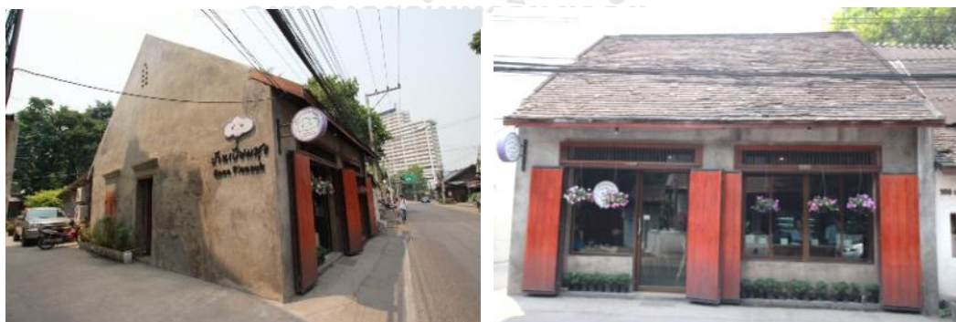
ภาพที่ 53 ภาพรวมของโครงการร้านบ้านเปี่ยมสุขด้านข้างร้าน (ด้านซ้าย) และด้านหน้า จากถนนเจริญราษฎร์ (ด้านขวา) จะเห็นประตูบานเพี้ยมที่ถูกรักษาไว้ โดยมีการติดตั้ง ชุดประตูหน้าต่างอลูมิเนียม สำหรับระบบปรับอากาศไว้ด้านใน ที่มา : ผู้วิจัย (2561)
