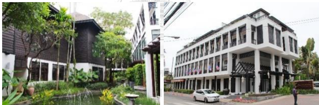
ภาพที่ 36 บริเวณเชื่อมต่อกับอาคารเก่าและอาคารที่สร้างใหม่ (ด้านซ้าย)
