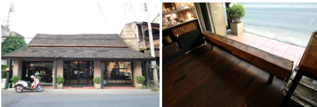
ภาพที่ 95 รูปแสดงเสาเหล็กด้านหน้าร้าน Woo Chiang Mai (ด้านซ้าย) ที่ถูกเปลี่ยนแทนเสาไม้ เนื่องจากถูกรถชน แล้วมีการนำเอาเสาไม้เดิมมาดัดแปลงเป็นม้านั่งภายในร้าน (ด้านขวา) ที่มา : ผู้วิจัย (2561)
