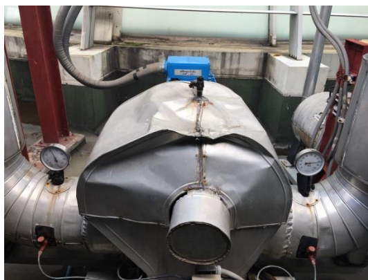
รูปภาพที่ ข- 4 ตรวจวัดความดันด้านดูด-ด้านจ่ายของเครื่องสูบน้ำเย็น
