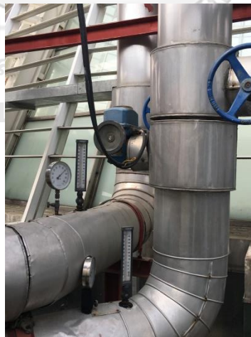
รูปภาพที่ ข- 3 ตรวจวัดความดันด้านดูด-ด้านจ่ายของเครื่องทำน้ำเย็น
