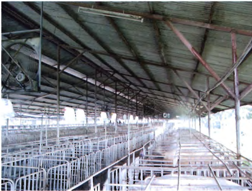
รูปที่ 18 พัดลมและน้ำฝอยในโรงเรือนสุกรอุ้มท้องฟาร์ม B
