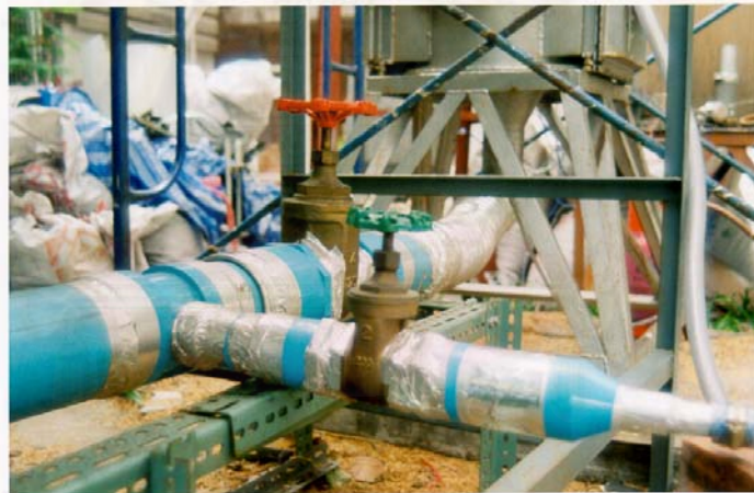
รูปที่ 5.8 แสดงภาพถ่าย Blower และท่อลมในระบบปรับอากาศ จุฬาลงกรณ์มหาวิทยาลัย
