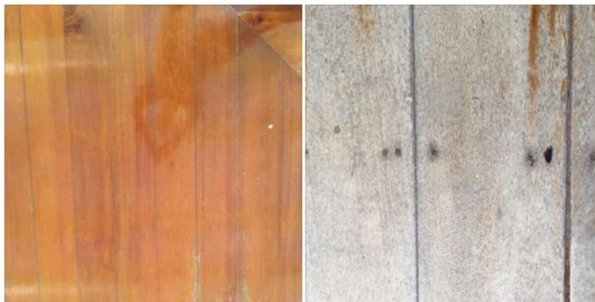
ภาพที่ 49 ภาพเทียบลักษณะหัวตะปูใหม่และเก่า ที่มา อริยะ ทรงประไพ
