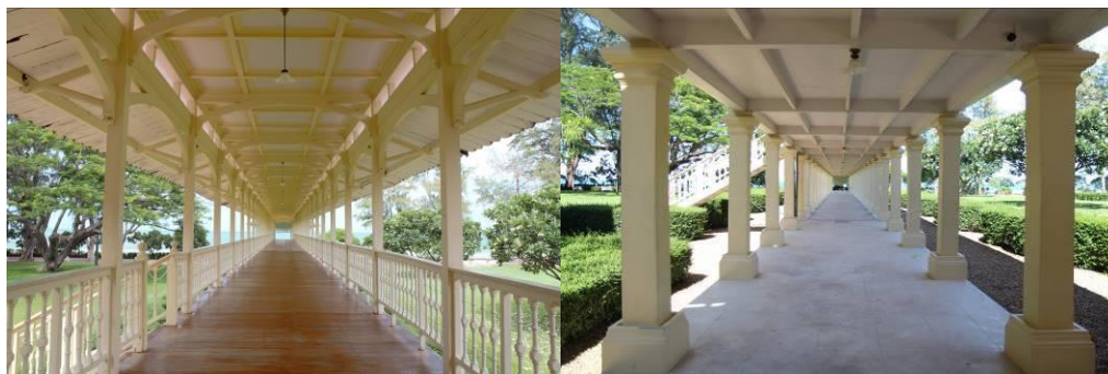
ภาพที่ 32 ภาพบริเวณทางเดินศาลาลงทรงฝ่ายหน้า ชั้นบนและชั้นล่าง ที่มา ผู้วิจัย
