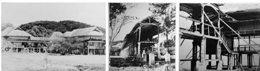
ภาพที่ 1 สภาพก่อนบูรณะปี 2530
