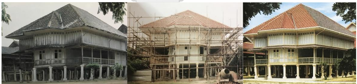
ภาพที่ 11 ภาพถ่ายห้องพระบรรทม ก่อนการบูรณะ ระหว่างบูรณะและบูรณะแล้วเสร็จ ในปี พ.ศ. 2536 ที่มา รายงานแบบบูรณะกรมศิลปากร
