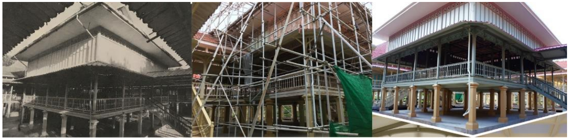
ภาพที่ 27 ภาพอาคารหอเสวยฝ่ายหน้าก่อนบูรณะ ระหว่างบูรณะ บูรณะแล้วเสร็จ
