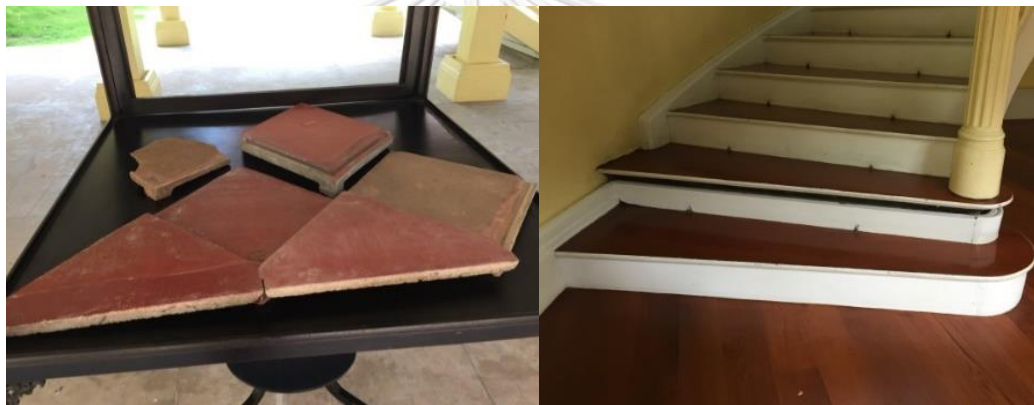
ภาพที่ 7 กระเบื้องว่าวซีเมนต์สีแดง และบันไดเวียนไม้สักทอง ในพระที่นั่งสโมสรเสวกามาตย์
