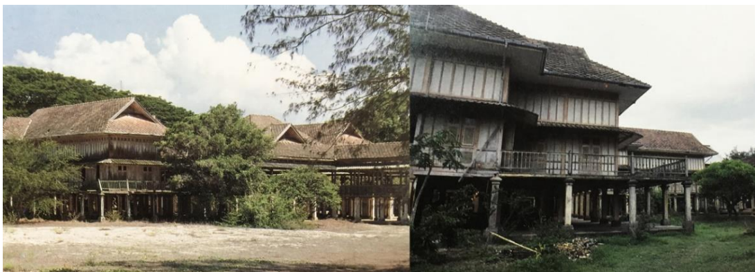
ภาพที่ 10 ภาพถ่ายเก่าโดยกรมศิลปากร สภาพความทรุดโทรมของหมู่พระที่นั่งก่อนการบูรณะปี พ.ศ.2530 ที่มา รายงานแบบบูรณะกรมศิลปากร
