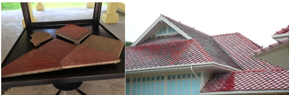
ภาพที่ 48 กระเบื้องว่าวที่เทียบขนาดและน้ำหนักของพระที่นั่งสโสมสรเสวกามาตย์ ที่มา ผู้วิจัย
