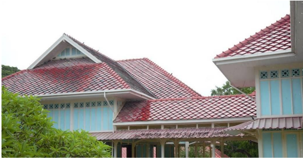
ภาพที่ 6 ส่วนหลังคา หลังคากระเบื้องว่าวซีเมนต์สีแดงหลังคากันสาดแผ่นไม้สักบริเวณหมู่พระที่นั่งพิศาลสาคร ที่มา ผู้วิจัย
