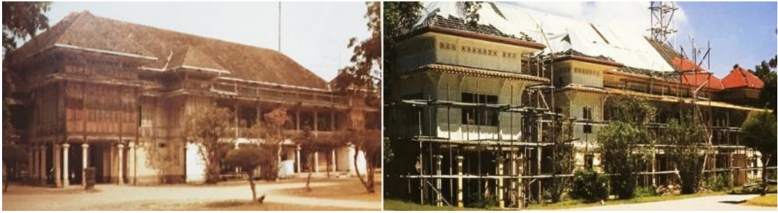
ภาพที่ 22 ภาพพระที่นั่งสโมสรเสวกามาตย์ก่อนบูรณะและระหว่างบูรณะ เมื่อปี 2536 ที่มา รายงานแบบบูรณะกรมศิลปากร
