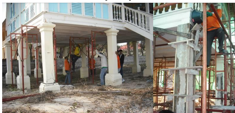
ภาพที่ 17 ติดตั้งนั่งร้านค้ำยันเพื่อความปลอดภัยของช่างและอาคาร ในการเทปูนหล่อเสาที่มา ห้างหุ้นส่วนจำกัด สุวานอนุรักษ์
