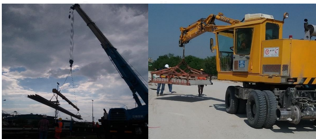
ก. เครื่องจักรขณะทำการยกวางและหมอนคอนกรีต
