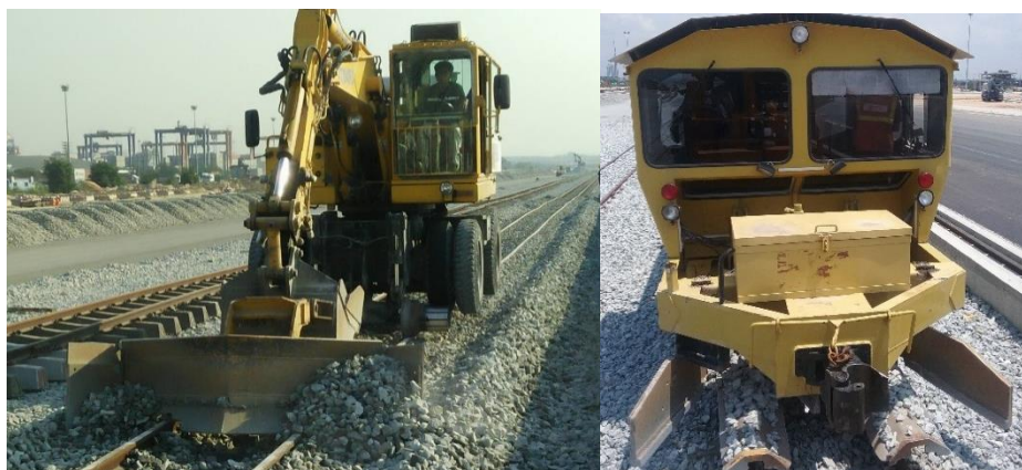
ข. เครื่องจักรขณะเกลี่ยหินหลังลงหินโรยทางและหลังการอัดหินโรยทาง
