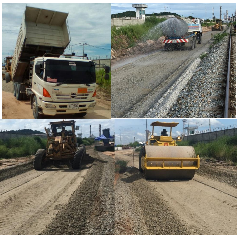
รูปที่ 4.5 เครื่องจักรขณะทำงานเทกองดิน ล้มกองดิน เกลี่ยและบดอัดแน่นดิน
