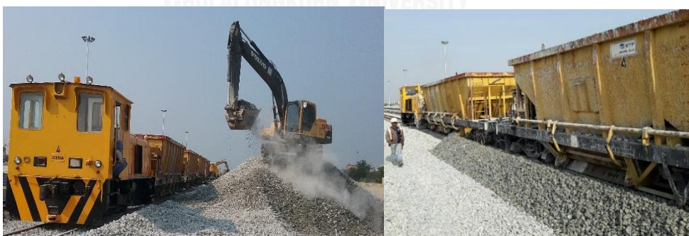
ก. เครื่องจักรขณะตักหินใส่รถบข.และลงหินในทาง
