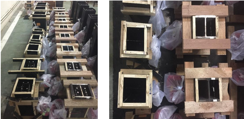
ภาพที่ 4.1 การเตรียมแบบหล่อสำหรับเสาคอนกรีต และเสา PCES
