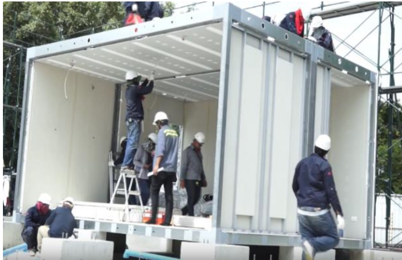
รูปที่ 2.1 โมดูลาร์ที่มีโครงสร้างเป็นเหล็กชนิดเติมรูปแบบและงานภายในแล้วเสร็จไม่สมบูรณ์
