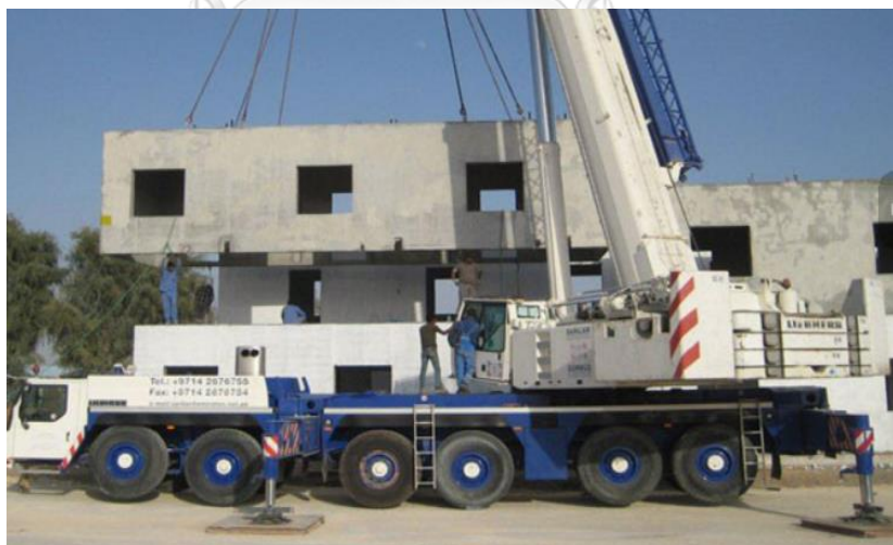
รูปที่ 2.1 โมดูลาร์ที่มีโครงสร้างเป็นคอนกรีตชนิดเติมรูปแบบและงานภายในแล้วเสร็จไม่สมบูรณ์
