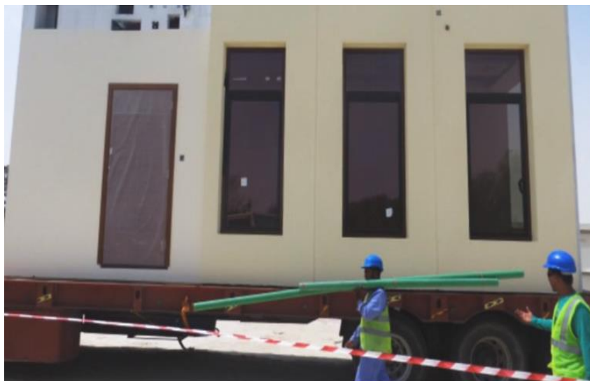
รูปที่ 2.18 โมดูลาร์ที่มีโครงสร้างเป็นคอนกรีตชนิดเต็มรูปแบบและงานภายในแล้วเสร็จสมบูรณ์ (ที่มา: Lawson et al., 2014)
