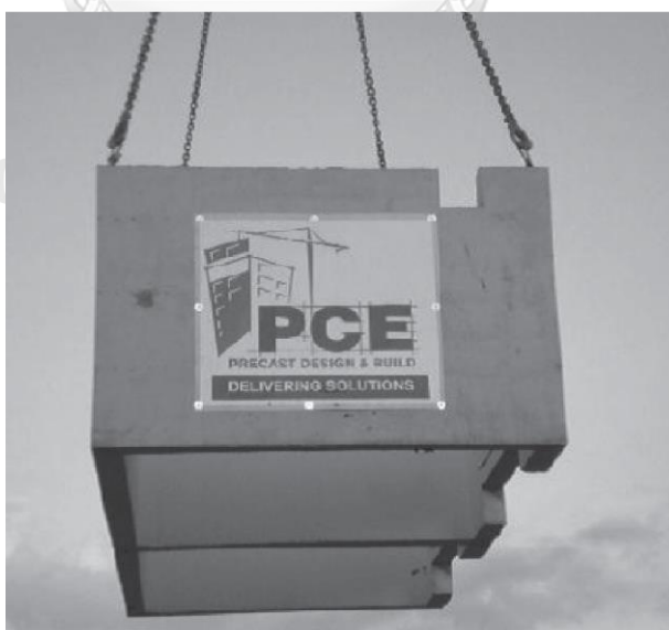
รูปที่ 2.24 โมดูลาร์ที่มีโครงสร้างเป็นคอนกรีตชนิดไม่เต็มรูปแบบและงานภายในแล้วเสร็จไม่สมบูรณ์ (ที่มา: Lawson et al., 2014)
