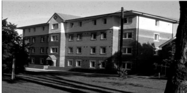
รูปที่ 2.7 อาคารพักอาศัยที่ก่อสร้างด้วยระบบโมดูลาร์ (ที่มา: Lawson et al., 1999)
