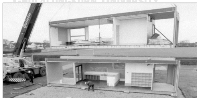
รูปที่ 2.9 อาคารเรียนที่ก่อสร้างด้วยระบบโมดูลาร์ (ที่มา: Lawson et al., 1999)
