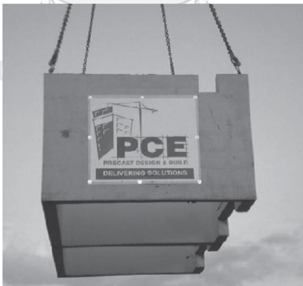
รูปที่ 4.2 โมดูลาร์ที่มีโครงสร้างเป็นคอนกรีตชนิดไม่เต็มรูปแบบและงานภายในแล้วเสร็จไม่สมบูรณ์
