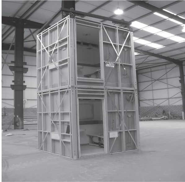
รูปที่ 4.1 โมดูลาร์ที่มีโครงสร้างเป็นเหล็กชนิดไม่เต็มรูปแบบและงานภายในแล้วเสร็จไม่สมบูรณ์
