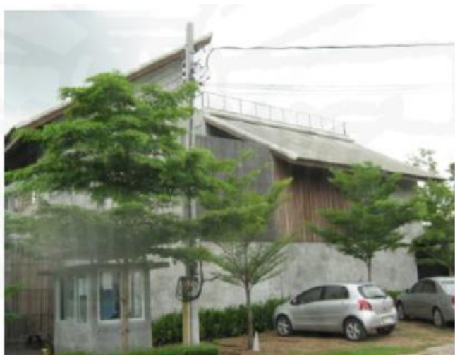
รูปที่ 2.14 บ้านพักอาศัย Ten House (ที่มา: ฐิตยา สารฤทธิ, 2553)
