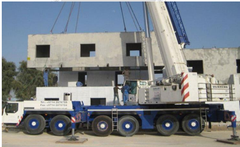
รูปที่ 2.1 โมดูลาร์ที่มีโครงสร้างเป็นคอนกรีตชนิดเต็มรูปแบบและงานภายในแล้วเสร็จไม่สมบูรณ์
