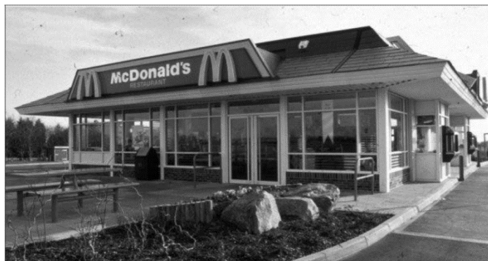
รูปที่ 2.8 อาคารร้านอาหารที่ก่อสร้างด้วยระบบโมดูลาร์ (ที่มา: Lawson et al., 1999)
