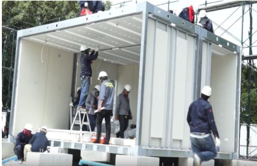
รูปที่ 2.19 โมดูลาร์ที่มีโครงสร้างเป็นเหล็กชนิดเต็มรูปแบบและงานภายในแล้วเสร็จไม่สมบูรณ์ (ที่มา: Lawson, 2007)
