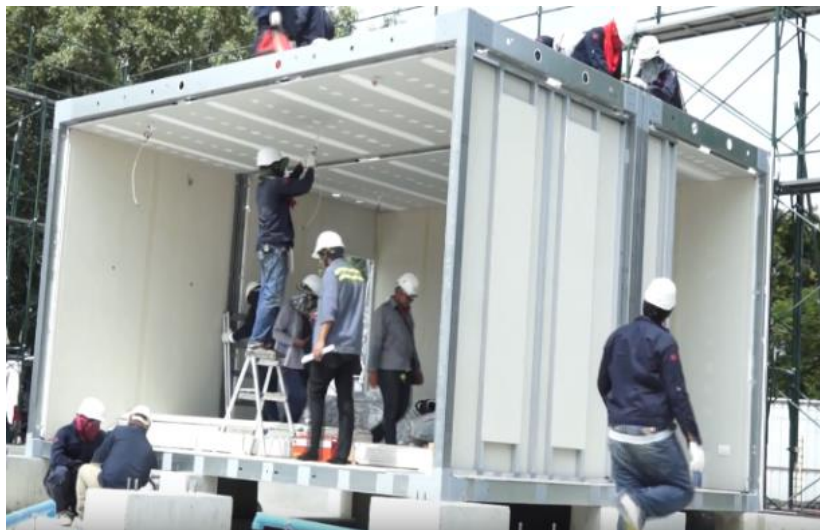
รูปที่ 2.1 โมดูลาร์ที่มีโครงสร้างเป็นเหล็กชนิดเต็มรูปแบบและงานภายในแล้วเสร็จไม่สมบูรณ์
