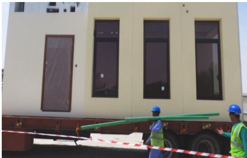
รูปที่ 1.2 โมดูลาร์ที่มีโครงสร้างเป็นคอนกรีตชนิดเต็มรูปแบบและงานภายในแล้วเสร็จสมบูรณ์
