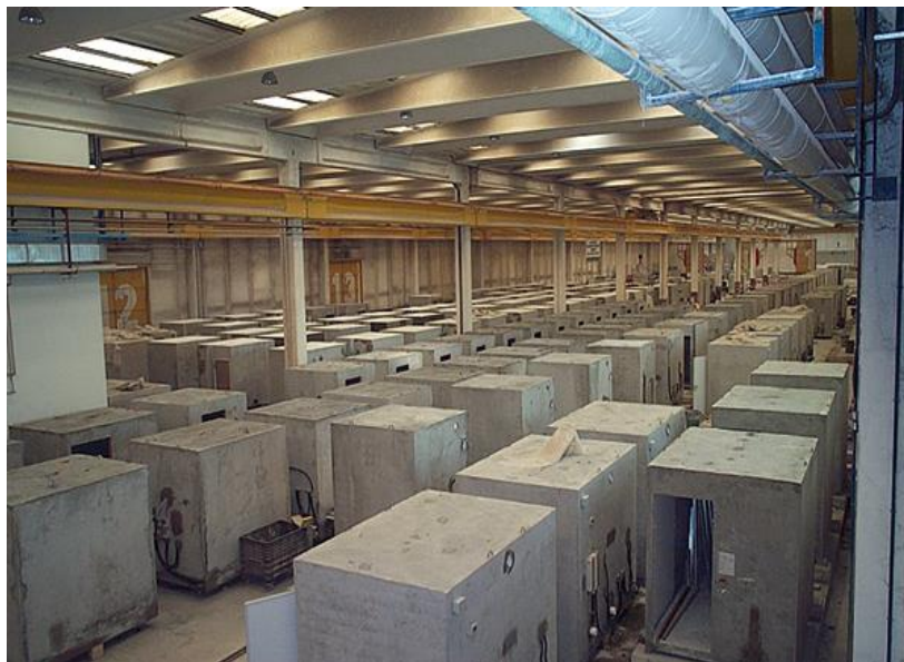
รูปที่ 2.22 โมดูลาร์ที่มีโครงสร้างเป็นคอนกรีตชนิดไม่เต็มรูปแบบและงานภายในแล้วเสร็จสมบูรณ์ (ที่มา: Lawson, 2007)
