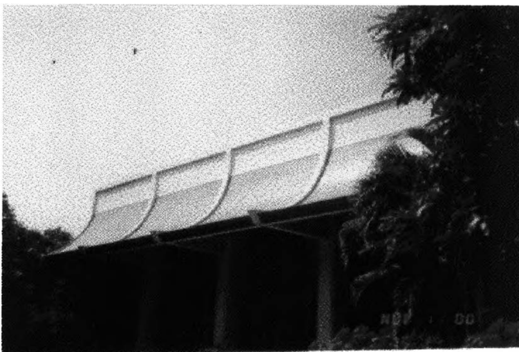
ภาพที่ 5 หลังคาของธรรมสถานได้รับการออกแบบให้สร้างด้วยคอนกรีต ปูด้วยโมเสกสีส้ม โดยมีช่วงจังหวะด้วยการยกคืบเป็นขั้นขึ้นมา
