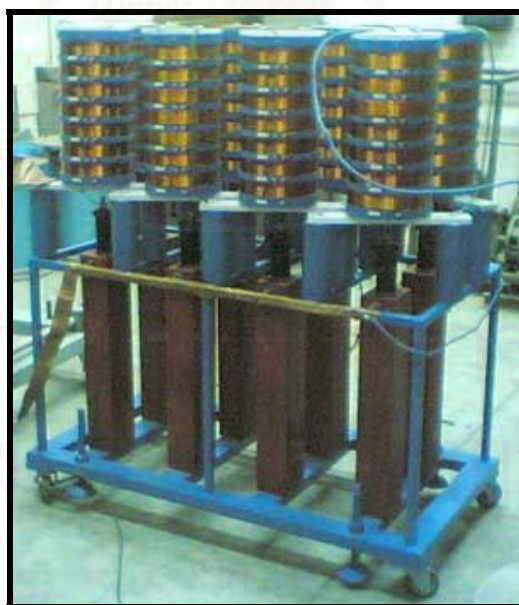
รูปที่ 3.4 การติดตั้งตัวเก็บประจุอิมพัลส์และตัวเหนี่ยวนำลงบนฐานเหล็ก
