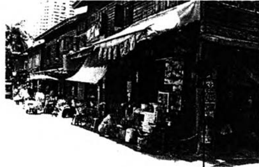
ภาพประกอบที่ 6.12 แสดงลักษณะสิ่งปลูกสร้างเรือนแถว 2 ชั้น
