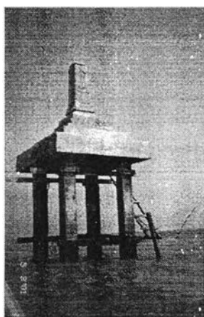
รูปที่ ง-43 หลักเขตกรุงเทพมหานครในสภาพปัจจุบันที่ได้รับการซ่อมแซมและยกระดับขึ้น
