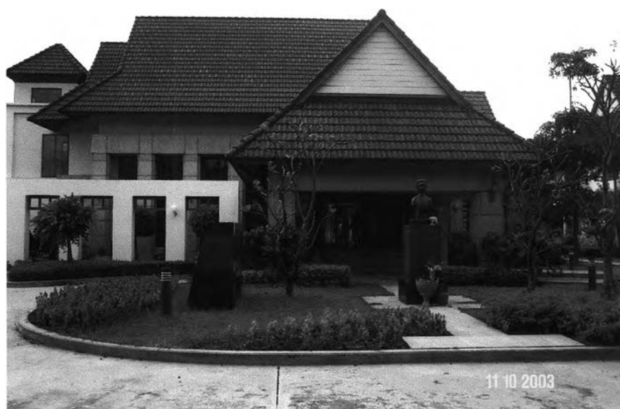
รูปที่ 4-16 แสดงบริเวณด้านหน้าของบ้านบุศยานิเวศม์
