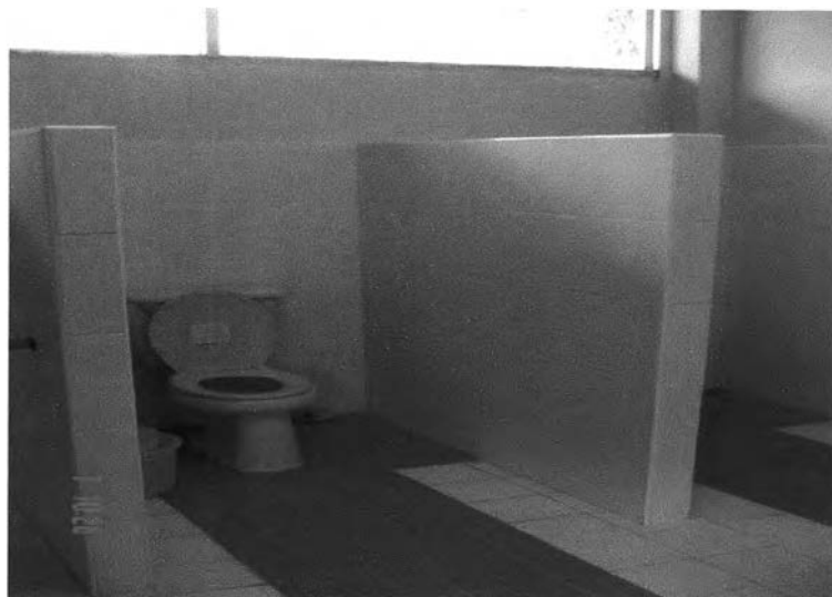
รูปที่ 4-33 แสดงห้องส้วมอาคารเรือนคนหลง ผู้ป่วย
