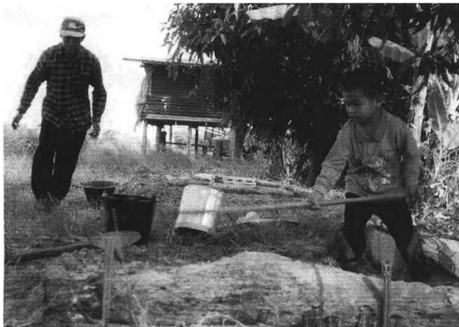
รูปที่ ฉ-12 แสดงภาพเด็กช่วยผู้ปกครองผสมปูนซีเมนต์เพื่อสร้างห้องน้ำ
