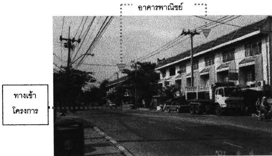
รูปภาพที่ 3.5 แสดงอาคารพาณิชย์หน้าโครงการ
