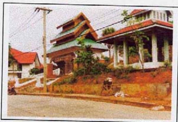
โครงการก่อสร้างปรับปรุงภูมิทัศน์วัดพระธาตุคอกงมู จำนวน 10,741,000 บาท
