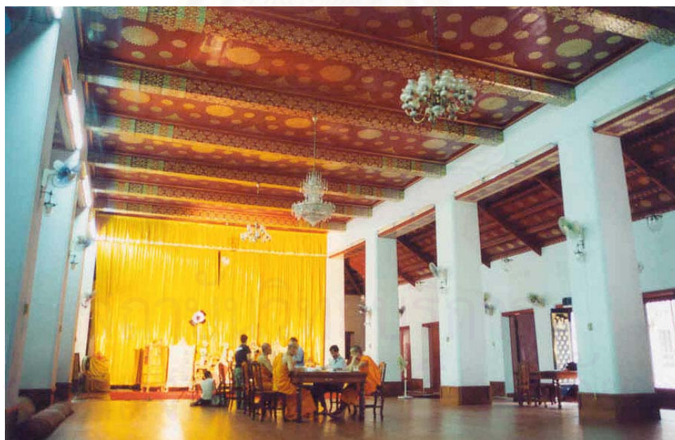
ภาพที่ ๔-๒๒ : ลักษณะอาคารที่มีเสาร่วมใน ตำหนักสมเด็จพระสังฆราช วัดมหาธาตุฯ
