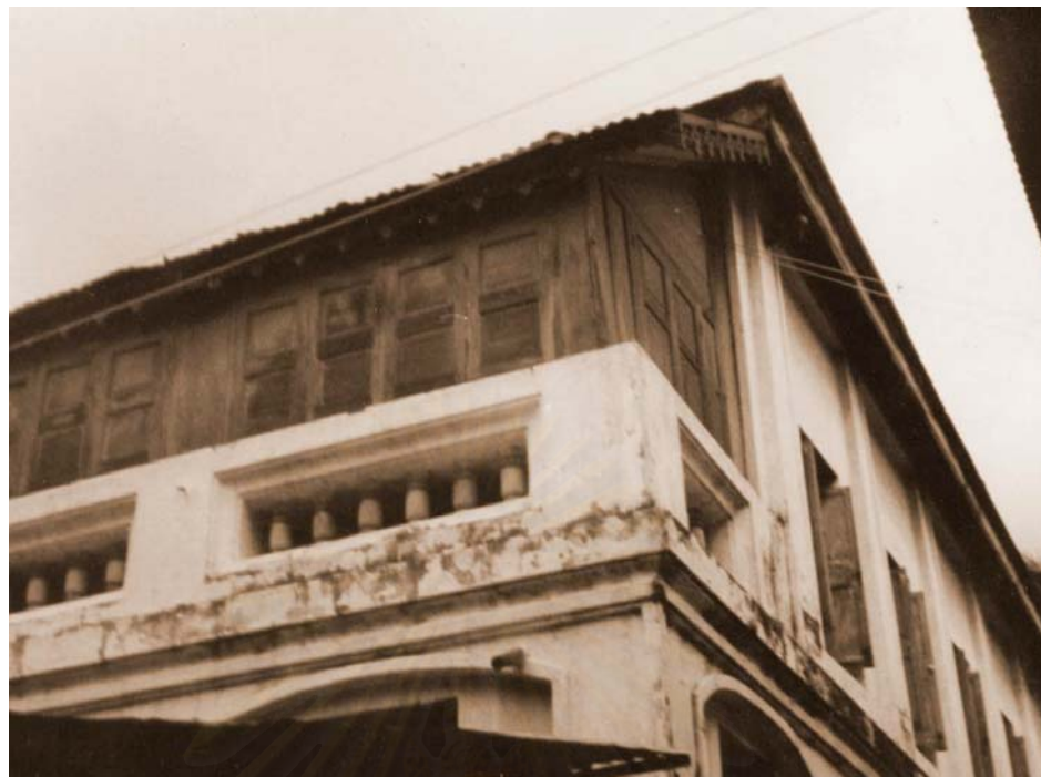
ภาพที่ ๓-๒๗ : สภาพเดิมของตำหนักสมเด็จพระสังฆราช (สา) ก่อนทำการบูรณะ จะเห็นได้ว่าบริเวณระเบียงด้านหน้านั้นเดิมกันผนังไม้เป็นห้องตรง
