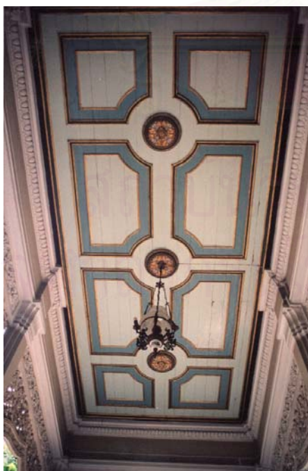
ภาพที่ ๔-๔๐ : ฝ้าเพดานของหอประชุมสงฆ์ที่ประดับตกแต่งด้วยบัวไม้ ฝ้าไม้
