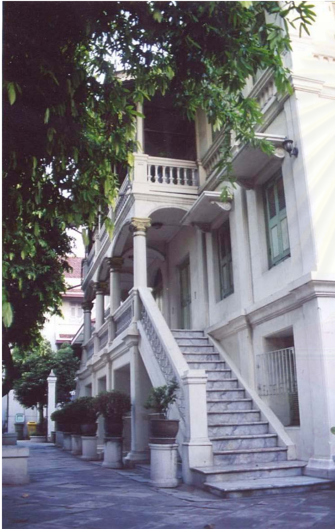
ภาพที่ ๓-๔๓ : บริเวณบันไดทางเข้าด้านหน้าของตำหนักอรุณ
