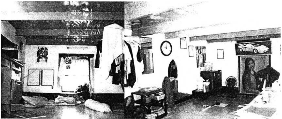
แสดงสภาพห้องชั้นล่าง พื้นถูกเทปูนปรับระดับสูงขึ้นจนเพดานต่ำใช้สอยไม่สะดวก
