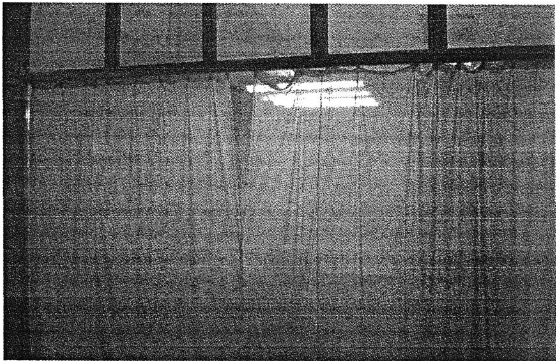
รูปที่ ข.15 แสดงการติดตั้งม่านกันฝุ่นละอองในหน่วยงานเรียงชุดกระดาษ
