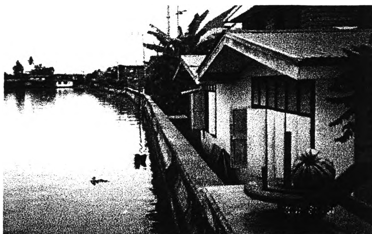
รูปภาพที่ 4.13 หลังก่อสร้างคันกั้นน้ำแนวเขตที่ดินริมคลองมีความชัดเจน
