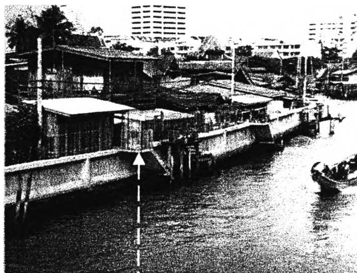
รูปภาพที่ 4.22 การก่อสร้างรั้วเพิ่มจากเดิม
