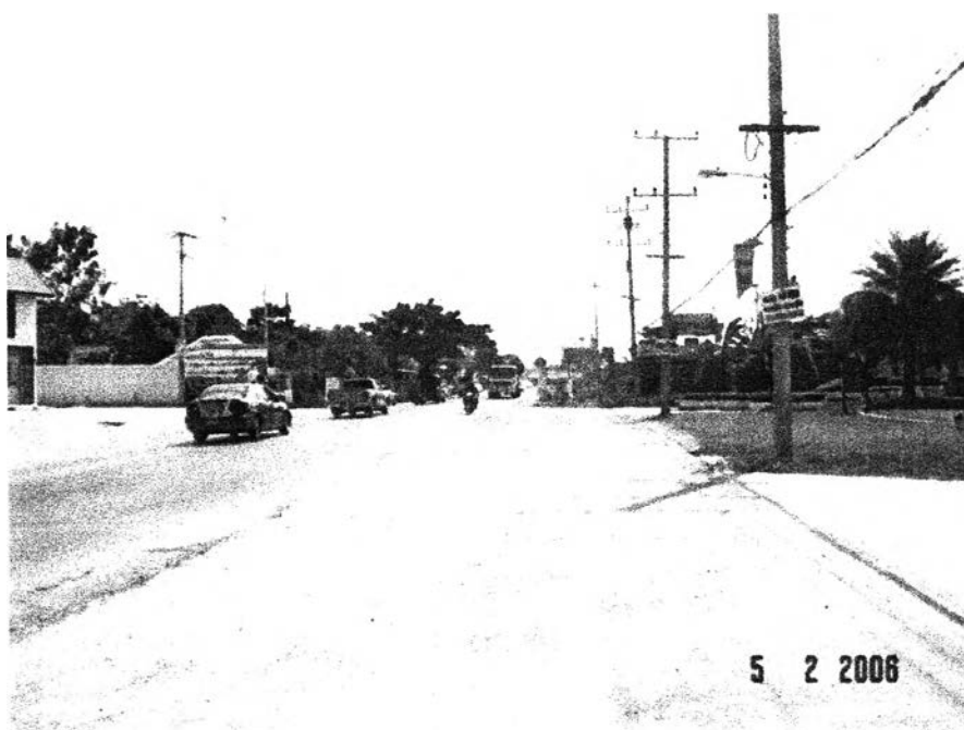
รูปภาพที่ 3.5.2 ภาพถ่ายถนนด้านหน้าโครงการ
