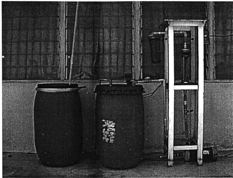
รูปที่ 3.5 การติดตั้งอุปกรณ์ต่างๆ ของระบบแผงรับแสงอาทิตย์
