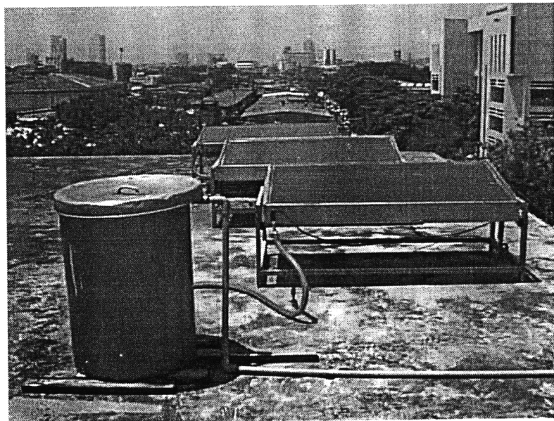
รูปที่ 3.4 แผงรับแสงอาทิตย์ต่อแบบอนุกรม 3 ชุด
