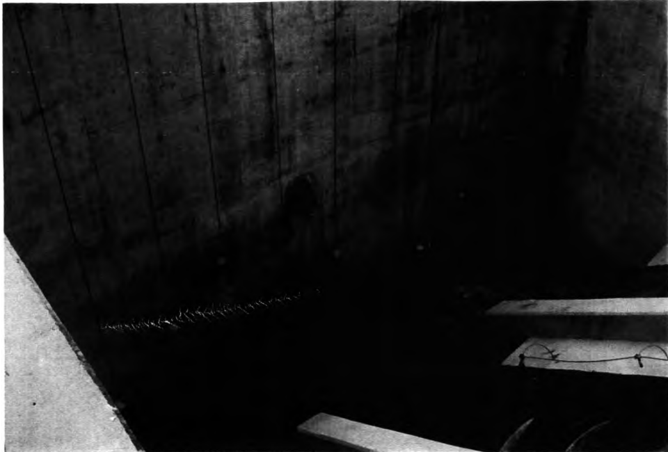
รูปที่ 1 ปอสูบน้ำเสียของกระบวนการบำบัดน้ำเสียโรงบำบัดน้ำเสียเคหะชุมชนห้วยขวาง
