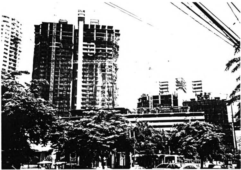
อาคารที่กำลังดำเนินการก่อสร้าง
