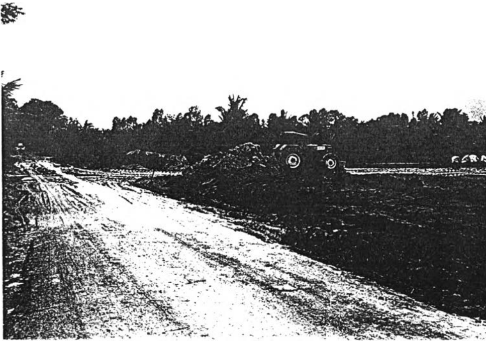
การปรับพื้นที่บริเวณแปลงทดสอบโดยการสูบน้ำและขุดลอกหน้าดิน
