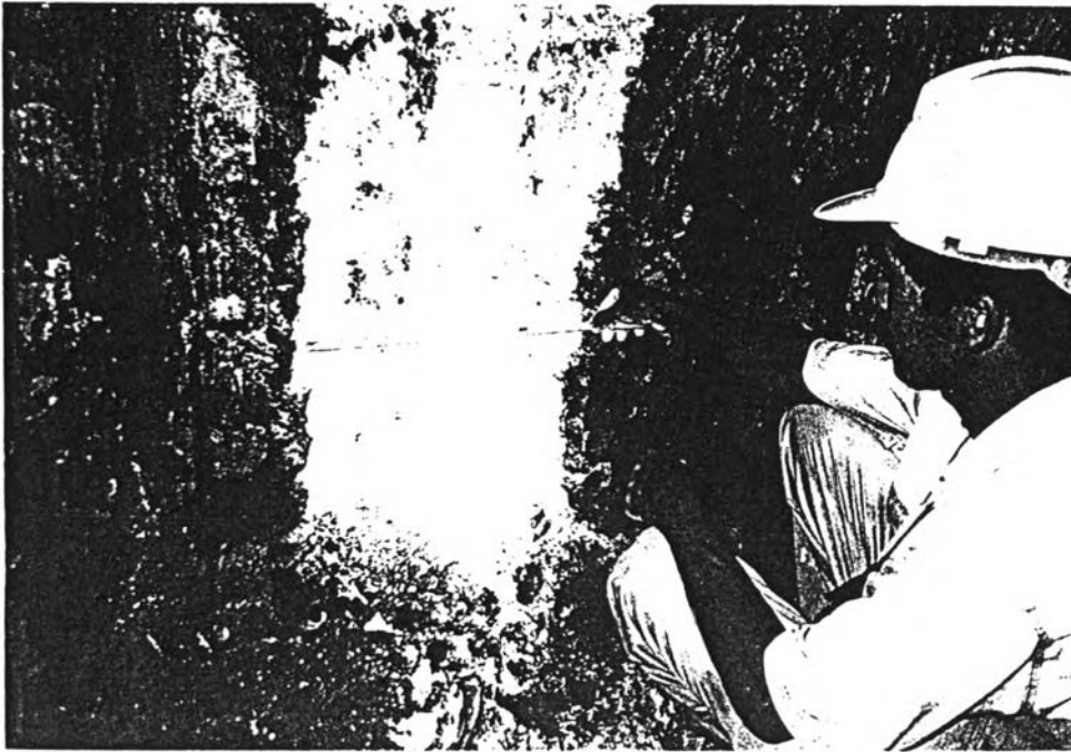
ลักษณะและขนาดของเข็มปูนขาวหลังการติดตั้ง 1 วัน
