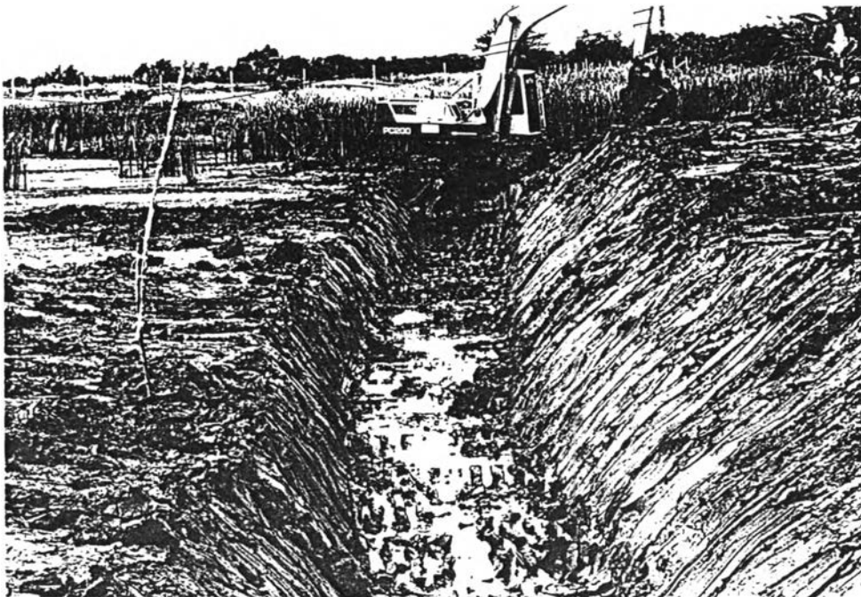
การก่อสร้างระบายน้ำโดยรอบบริเวณที่จะก่อสร้างแปลงทดสอบ
