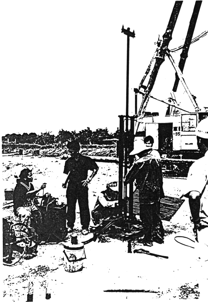
การทดสอบ Dutch Cone Penetration Test
