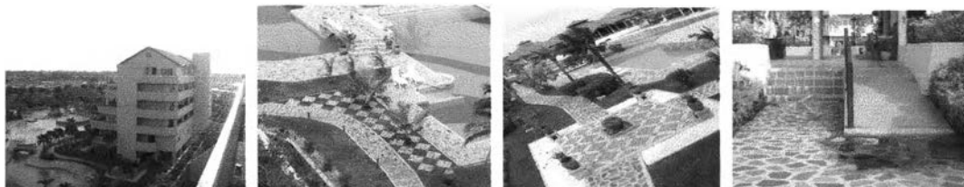
ลักษณะอาคารพักอาศัย ทางเท้าริมสระน้ำ ทางเดินระหว่างอาคาร ทางลาดและบันได
