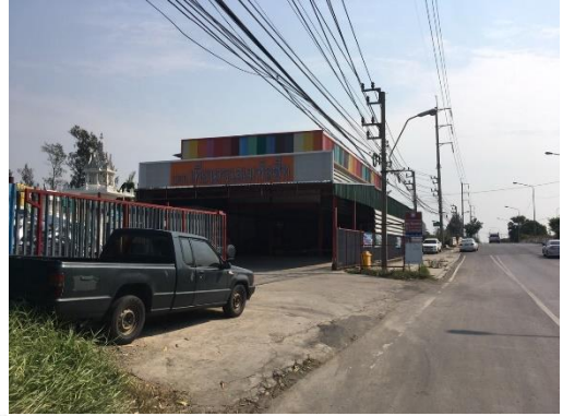
รูปที่ จ-2 ร้านหลังคาเมทัลชีท
