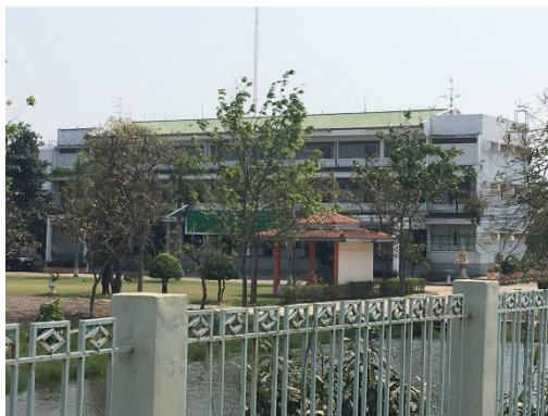
รูปที่ จ-5 อาคารกรมที่ดิน 3 ชั้น หลังคาเขียว
