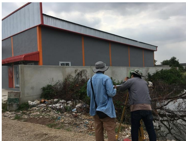
รูปที่ 4.17 การรังวัดตำแหน่งมุมอาคารด้วยกล้อง Total Station
