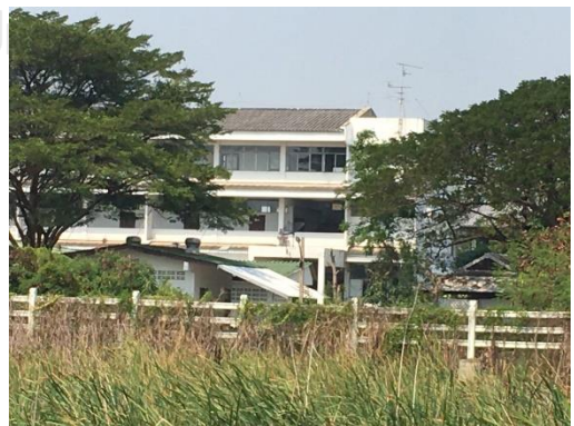
รูปที่ จ-6 อาคารกรมที่ดิน 3 ชั้น ขาว
