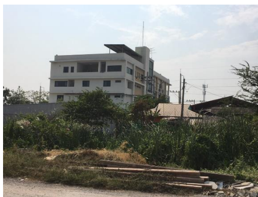
รูปที่ จ-11 อพาร์ตเมนต์ 4 ชั้น ขาว
