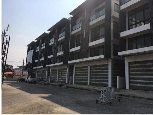
รูปที่ จ-1 อาคารพาณิชย์ 4 ชั้น เขียว-ขาว
